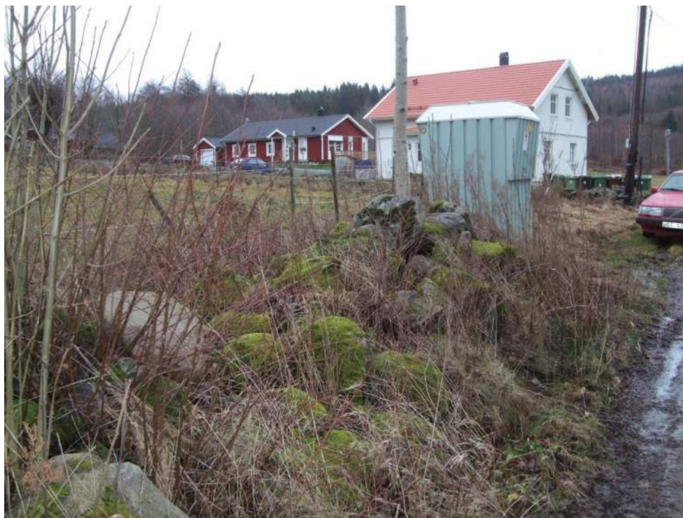
Muren är mer raserad i den sydligaste delen, närmast Kärrbogata.
