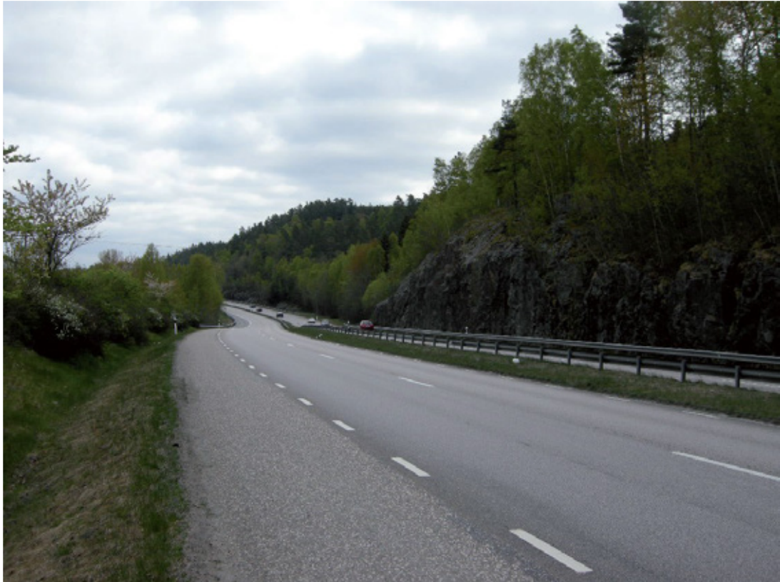
E20 följer den branta sluttningen mot sjön Sävelången. På vägens högra (östra) sida finns höga bergskärningar.
