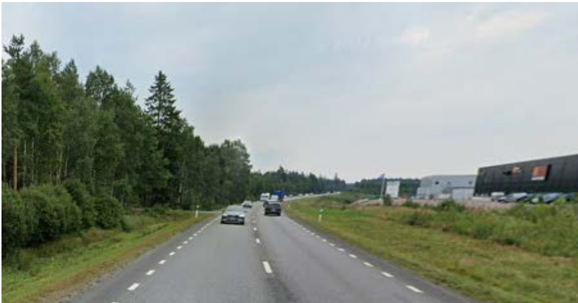
Figur 4.1:1 Befintlig väg 27 förbi Bredastens industriområde (källa: Google Maps).
