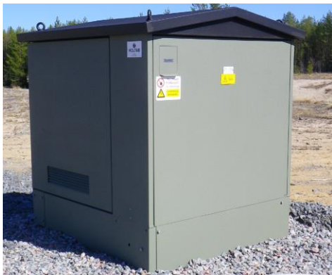
Figur 5. Exempelbild på hur en elanläggning längs elvägen kan se ut.
