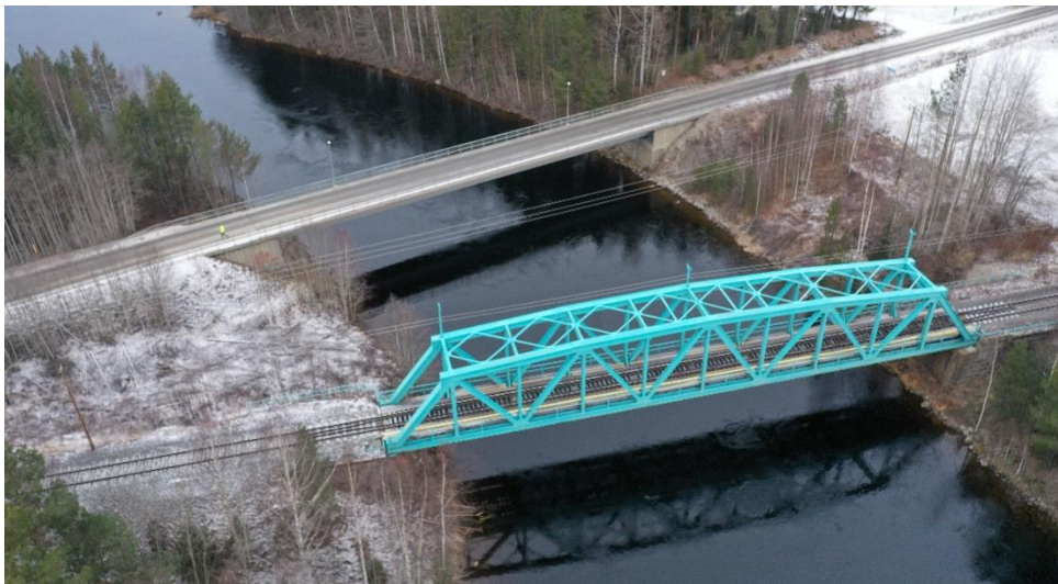
Figur 16. Befintlig väg- och järnvägsbro över Ljungan.
