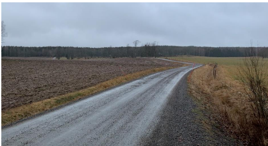
Figur 64. Äldre vägavsnitt av väg 542 mellan Remmene och Remmenetorp. Foto från nordost. Foto: Johan Richardson, Värmlands Museum.
