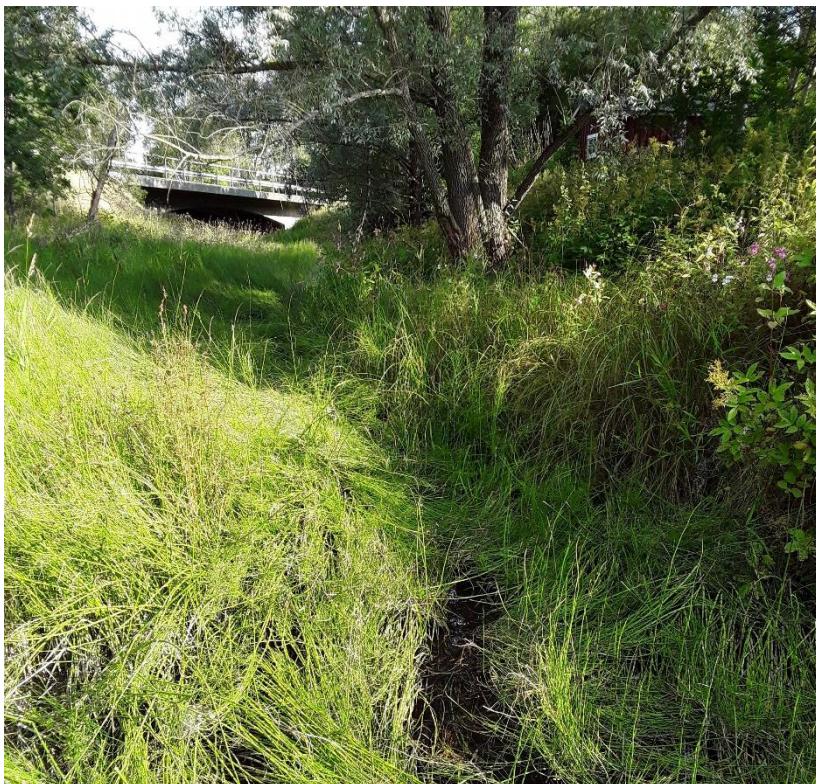
Figur 2. Slöan med befintlig bro i bakgrunden
