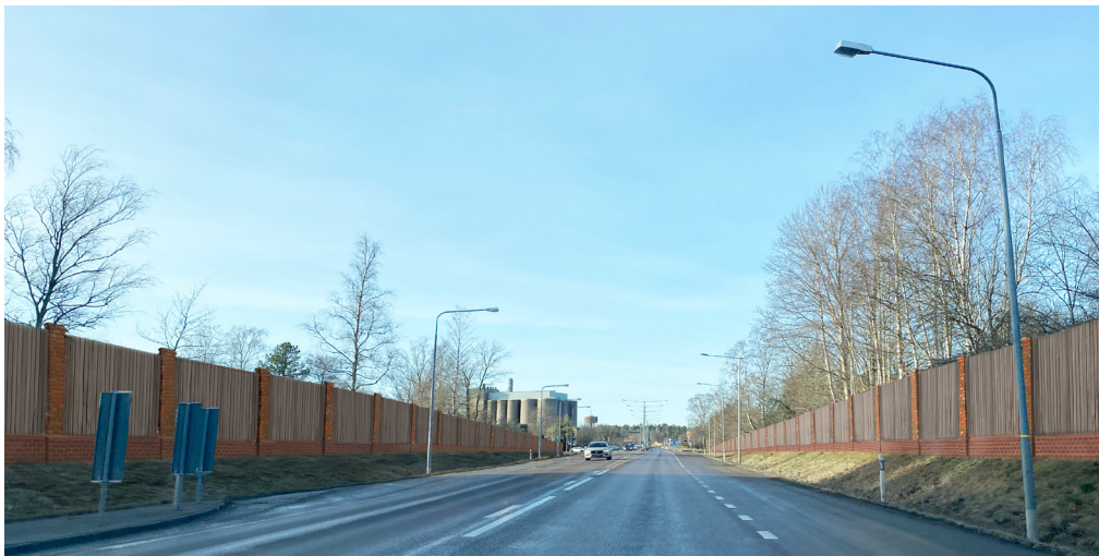
Figur 21. Vy/ fotomontage med bullerskyddsskärm, alternativ tegel och trä. Inslag av genomsiktliga partier kan förekomma även i detta utformningsalternativ.
