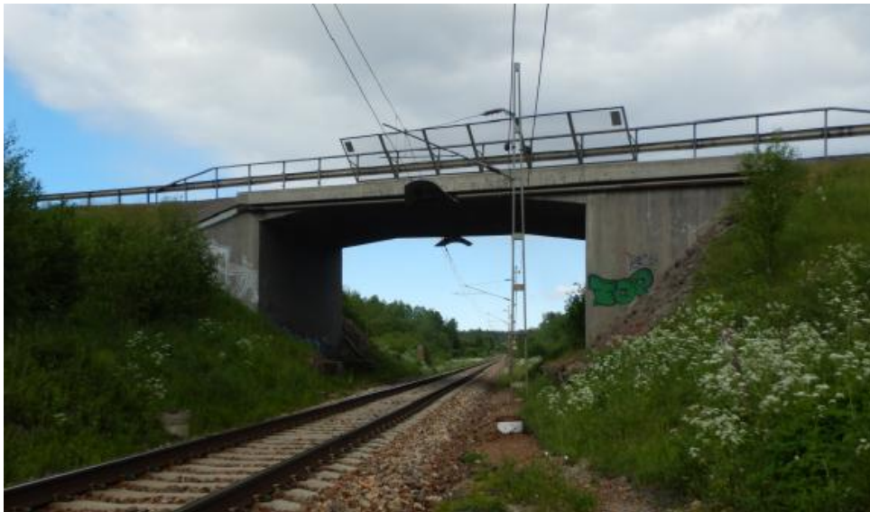
Figur 8. Befintlig vägbro över Ostkustbanan som breddas.
