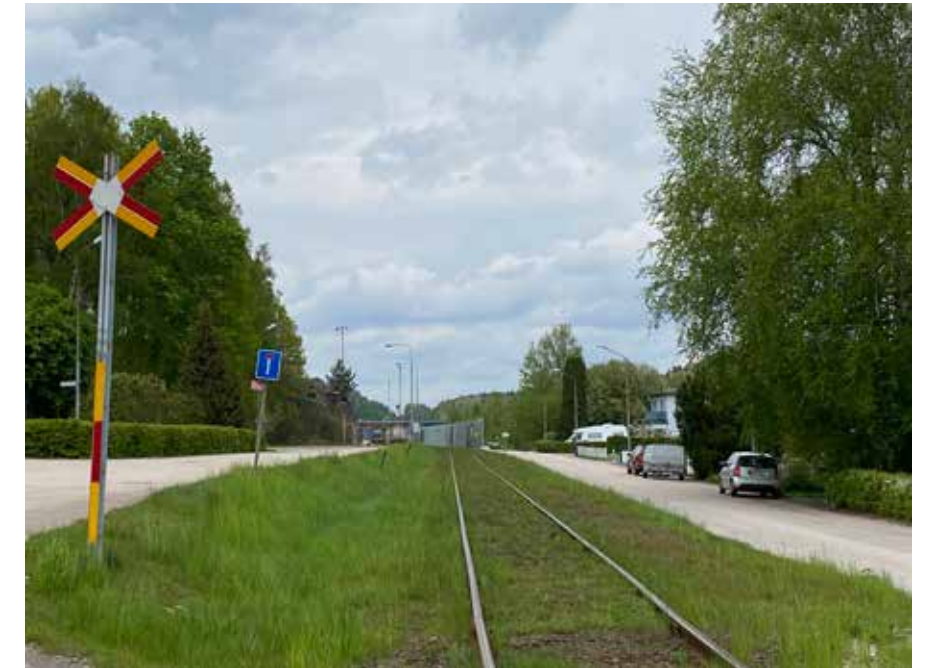
Figur 5.8. Sydostlänkens befintliga sträckning mellan Älmhult och Olofström slutar vid utdragsspåret söder om bangården i Olofström.
