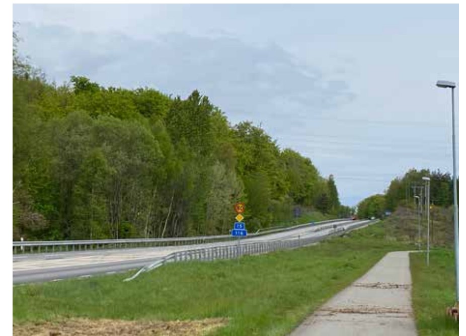
Figur 5.9. Gemensam dragning av väg 15/väg 116 söder om Olofström.
