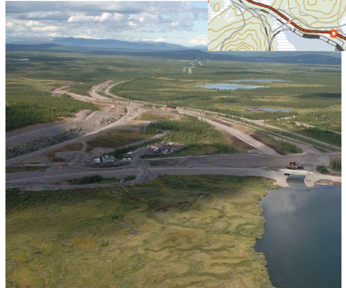
Byggnation av triangelspår Peuravaara 2011. Foto Trafikverket.
