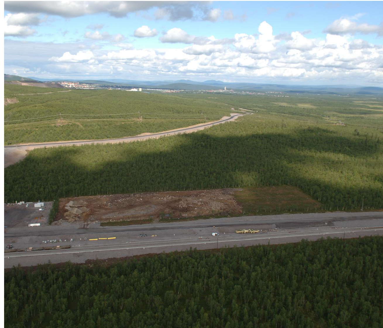
Godsbangård Kirunavaara under byggnation 2011. Foto Trafikverket.
