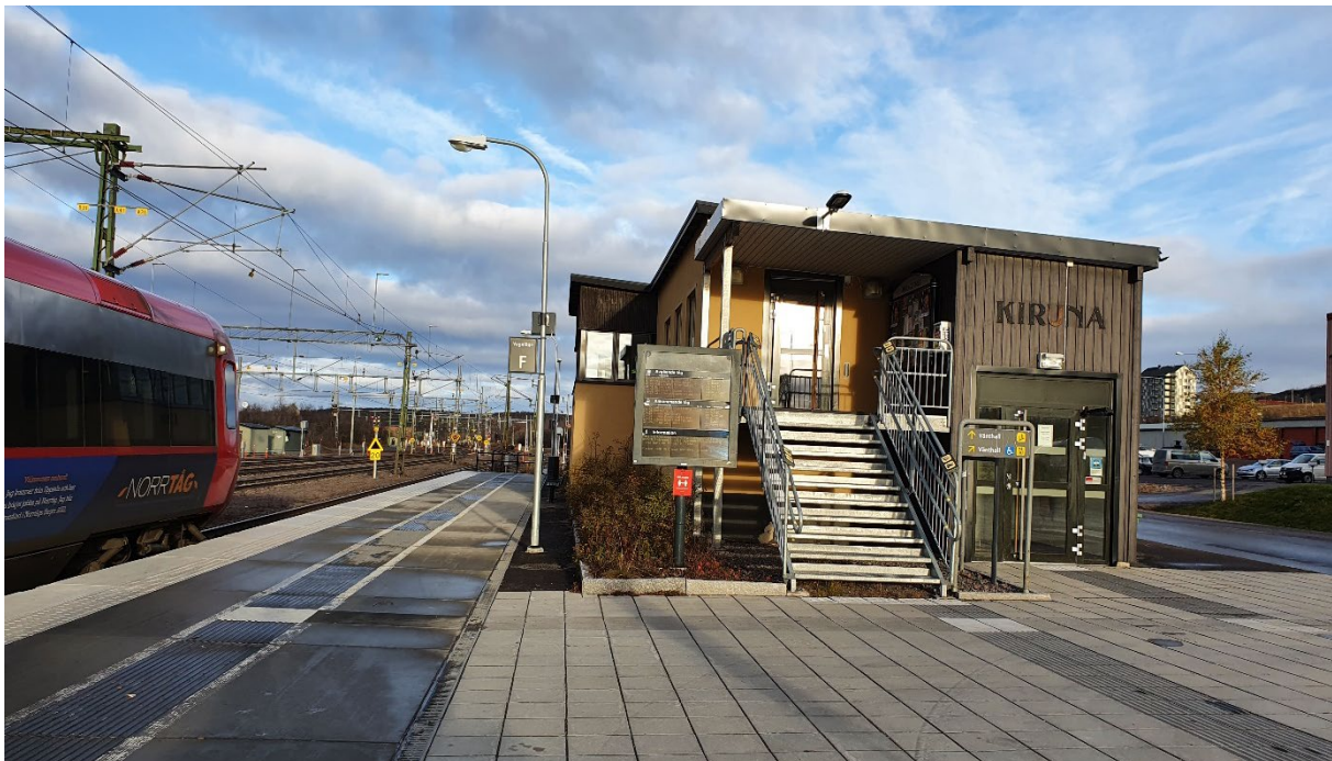
Figur 4.1 Kiruna nuvarande järnvägsstation vid Kiruna malmbangård.
