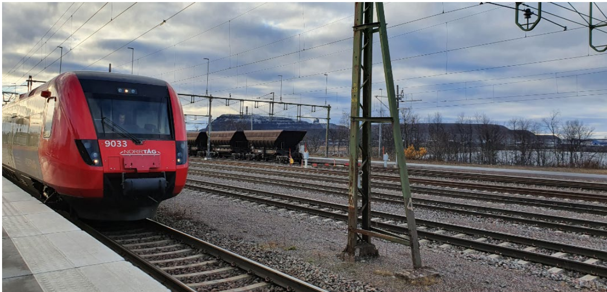
Figur 4.15 Vy från befintligt stationsläge mot gruvberget.
