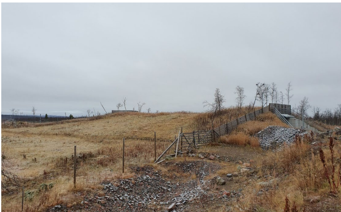
Figur 43. Befintlig faunapassage vid KIA.
