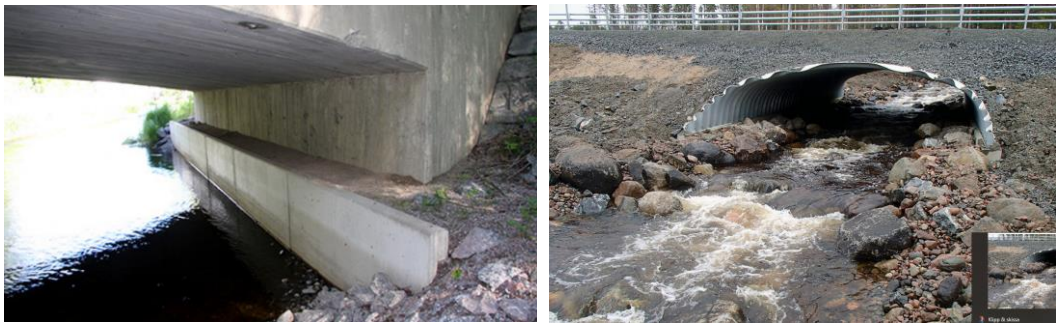
Figur 49. Exempel på strandpassager av betong och naturmaterial. Bilder från Trafikverkets temablad.
