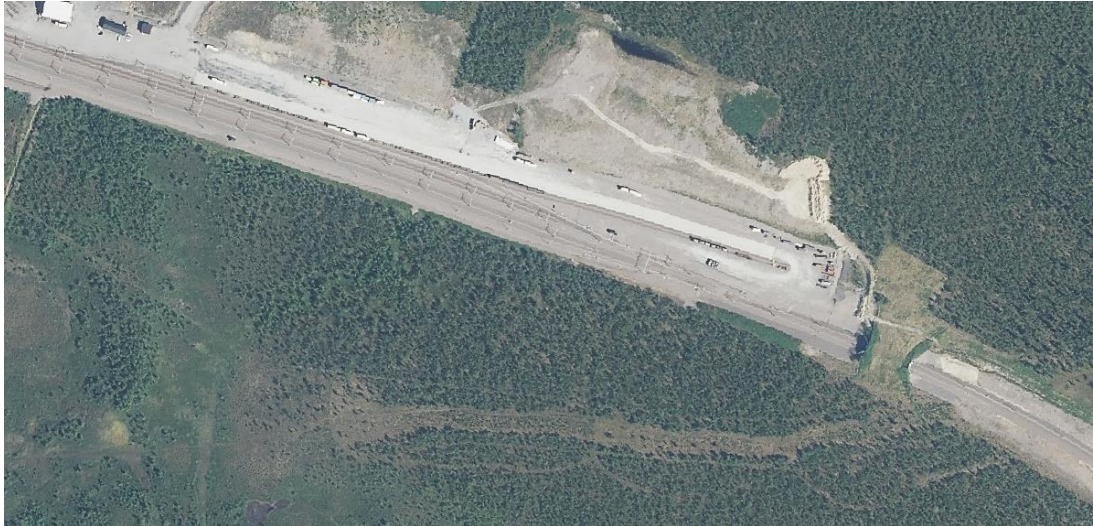
Figur 40. Godsbangården har byggts ut och sträcker sig nu ända fram till faunapassagen.
