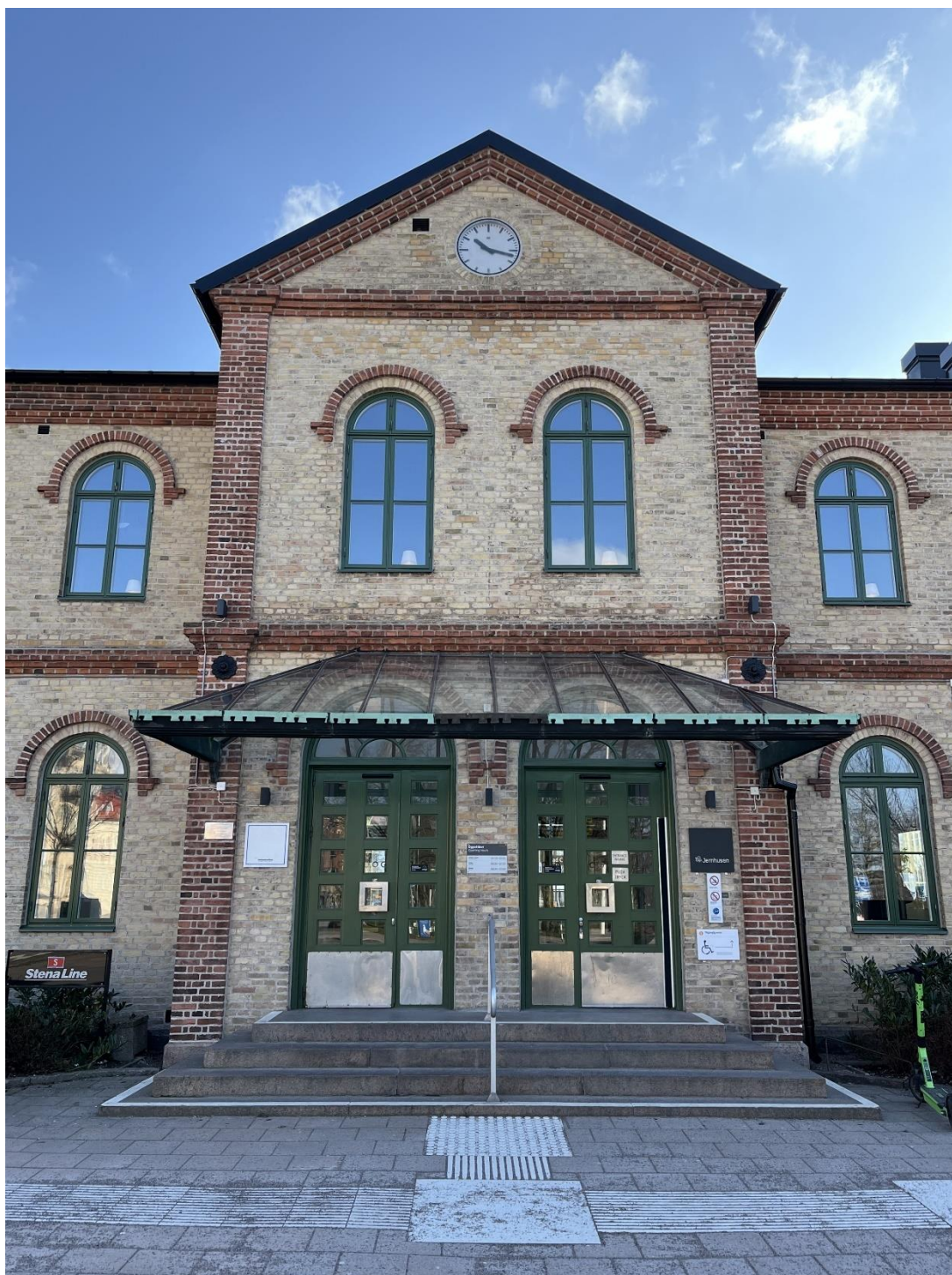
Figur B4. Stationshusets entréparti från Stationsgatan.
