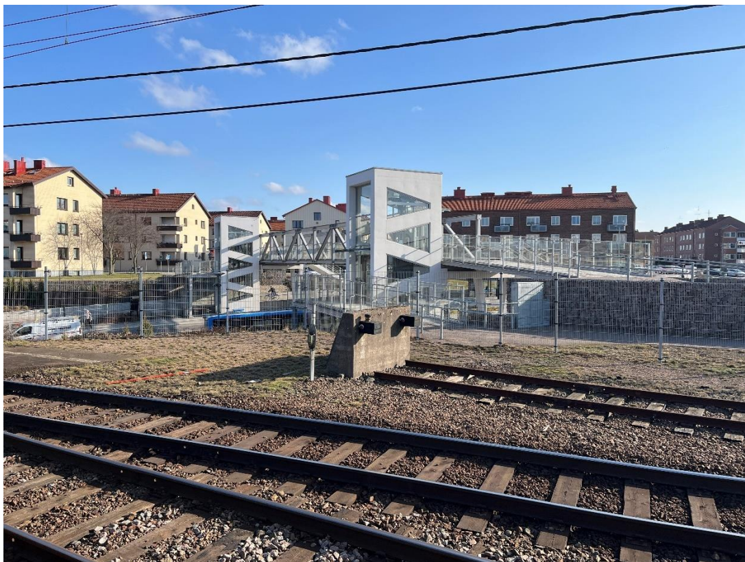
Figur B29. Stoppbock i betong med gummibuffertar.
