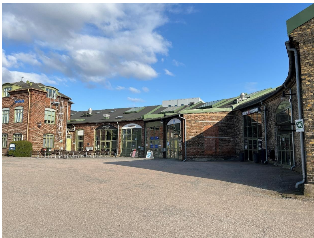
Figur B16. Ett av HNJ:s gamla lokstall med sju portar är sammanbyggt med en större verkstadsbyggnad som knappt syns i bild. Verkstadsbyggnaden ligger bakom kontorsbyggnaden med två våningar som syns till vänster i bild. Även kontorsbyggnaden är sammanbyggd med verkstadsbyggnaden.
