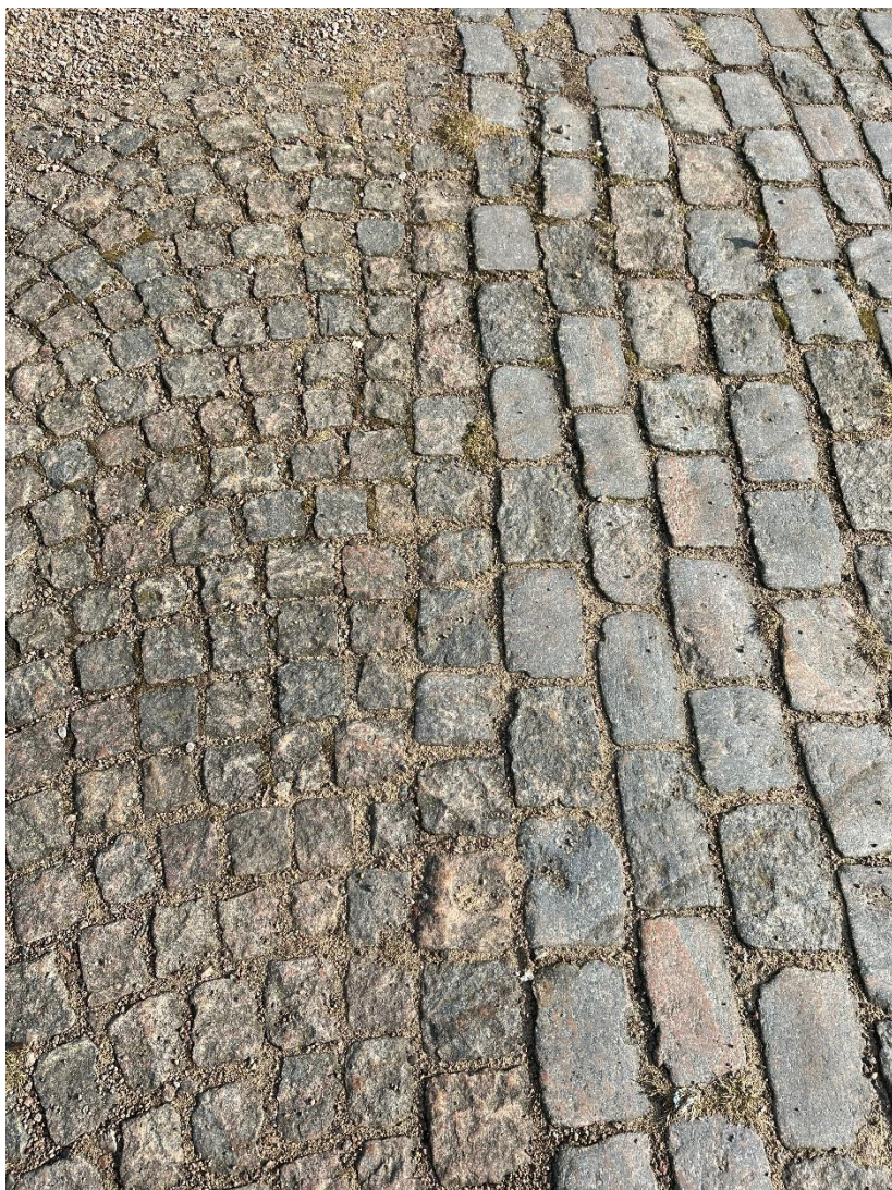
Figur B33. Stenläggning med mindre "knott", kvadratiske gatstenar och lite större rektangulära stenar.
