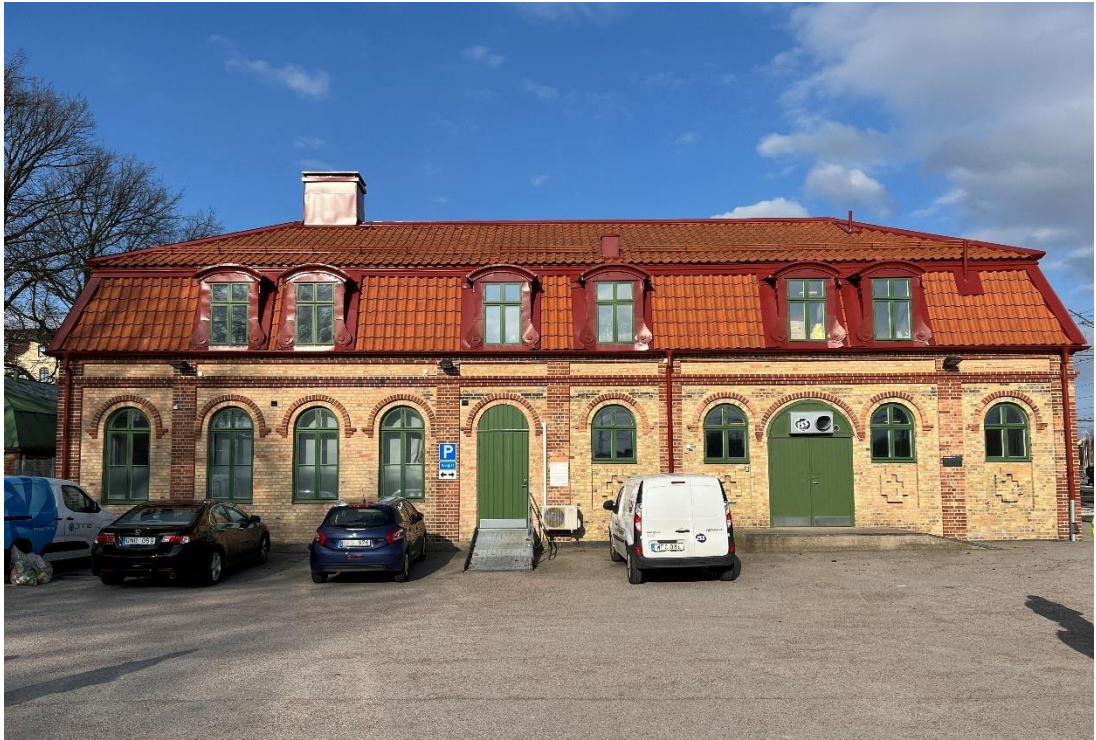
Figur B5. Ilgodsbyggnadens fasad mot söder. Stationens plattformar ligger precis utanför bild åt höger.
