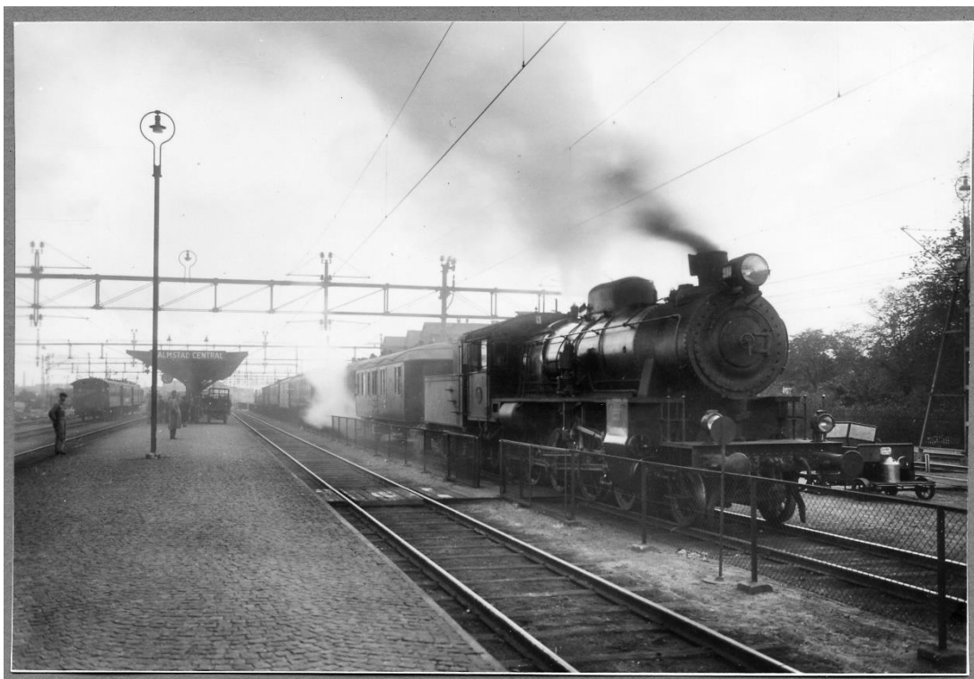
Figur 14 Foto från 1938 några år efter elektrifieringen av stationen genomförts. Ångloket på spår 2 tillhör HNJ och är bara några år gammalt, byggt av Nohab 1931. Sträckan Halmstad - Nässjö är än idag inte elektrifierad varför ångloken fortsatte att rulla genom Halmstad även efter elektrifieringen. På spår 5, mitt i bild till vänster, står ett ellok med ett kort persontåg och väntar på nya uppdrag.
