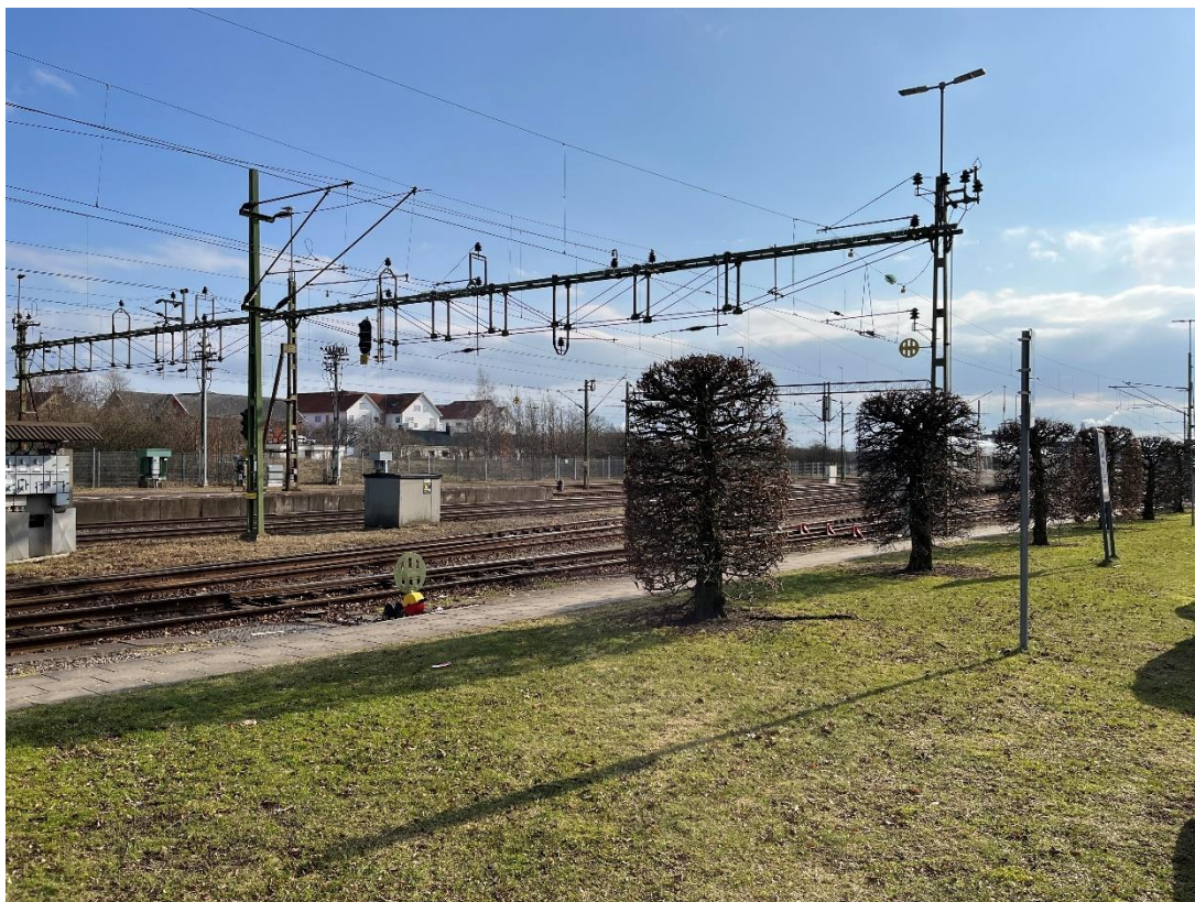
Figur B11. I anslutning till parkeringen söder om stationshuset står en rad med formklippta träd intill spårområdet.
