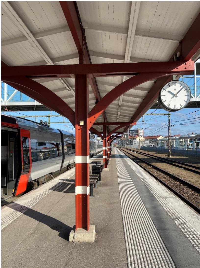
Figur B28. Plattformstaket vid spår 3 och 4 sett mot norr. Taken bärs upp av en limträkonstruktion monterad på stålbalkar. Plattformarna har moderna taktila stråk med vita plattor. Även bänkar, skyltar, avgångstavlor och papperskorgar är moderna. Plattformområdet är generellt fattigt på äldre attribut.
