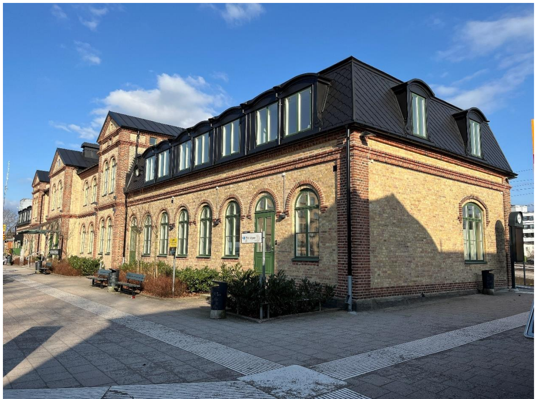
Figur B3. Stationshusets fasad mot Stationsgatan sedd från sydväst. Den södra tillbyggnaden är närmast i bild. Precis utanför bild till höger ligger plankorsningen för gående till plattformarna för spår 1 till 4. Bakom ryggen på fotografen ligger Ilgodsbyggnaden och Pressbyråkiosken. Se figur B5 nedan.
