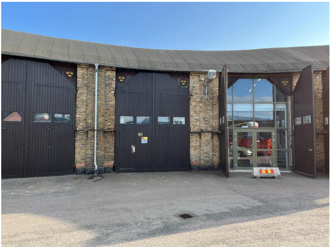
Figur B19. Av de tre bevarade rundstallen är detta det som är bäst bevarat sett till att de äldre portarna fortfarande finns kvar. Bakom de två högra portarna har dock en modern glasad fasad satts in varför portarna står permanent öppna. Ovanför portarna sitter rundlar med förgyllda tre kronor i relief.
