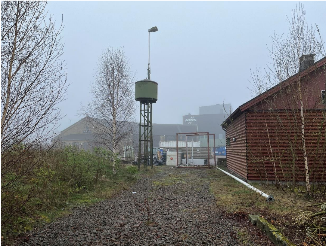
Figur B20. En äldre oljecistern eller liknande står på fackverksstolpar i anslutning till lokstallet närmast nuvarande spårrområde. Det plåtinklädda huset till höger kan i grunden vara ett äldre manskapshus från tidigt 1900-tal.
