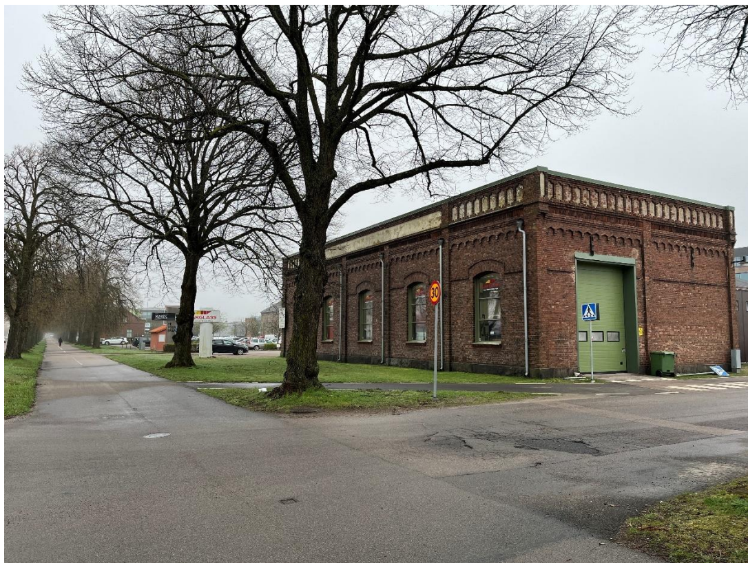
Figur B23. Ett parallellstall står närmast Järnvägsgatan i södra delen av området. Det tillsynes platta taket består av sågtak bakom de dekorativa putsade fälten överst på tegelfasaden. Byggnaden ska ha fungerat som både motorvagnsstall och måleriverkstad. Till vänster i bild, delvis dold av allén skymtar förrådsbyggnaden.
