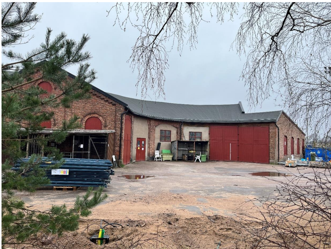
Figur B14. Halmstad Bolmen järnvägars lokstall sett från nordost. Rundeln vänder sig mot det tidigare spårområdet som gick öster om HBJ:s stationshus.
