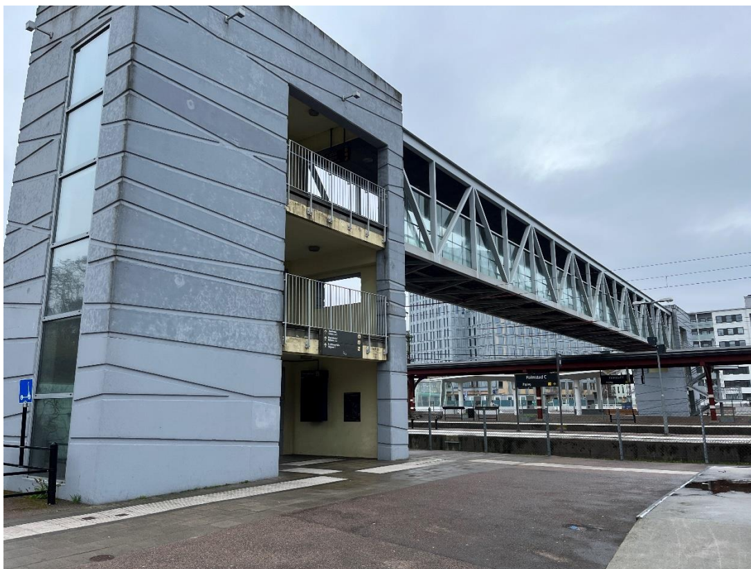
Figur B26. Gångbron över spåren från 2012 sedd från väster. Busstationens vita pelare skymtar under gångbron på andra sidan spåren.
