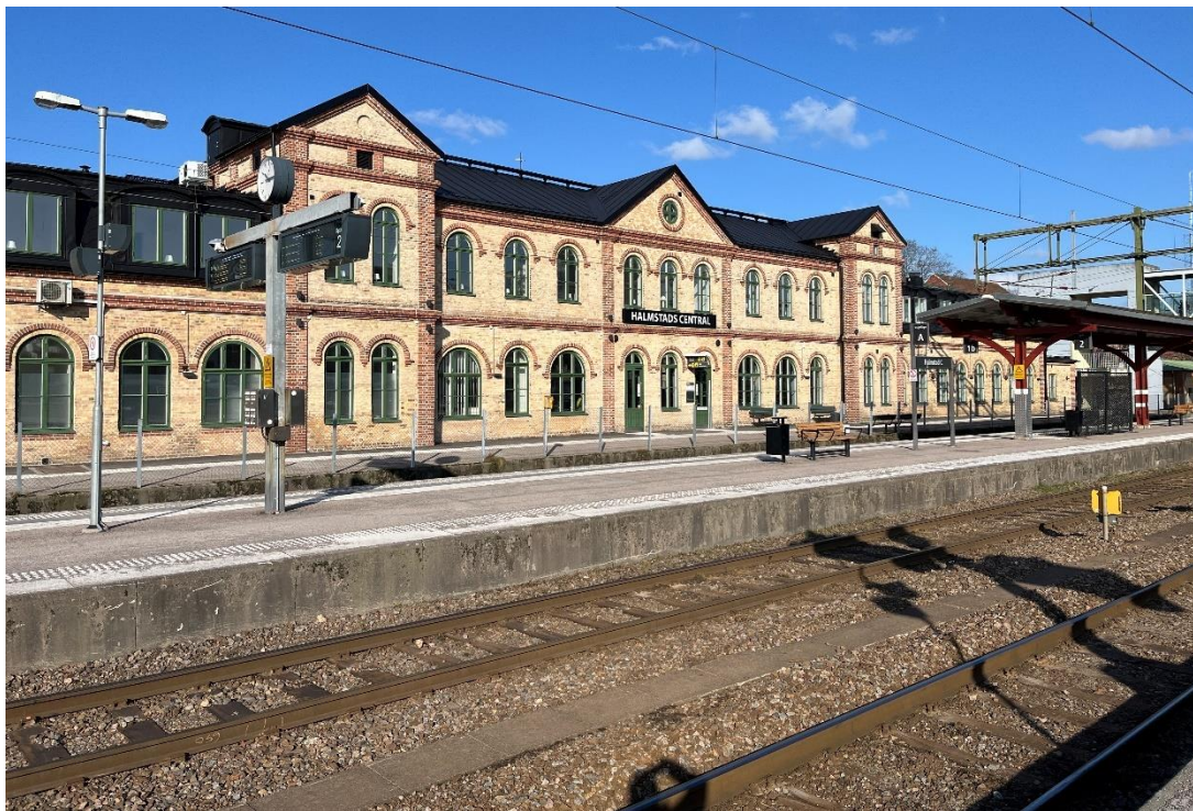
Figur B1. Stationshuset i stationshusområde A sett från södra delen av plattformen mellan spår 3 och 4. Den ursprungliga högre delen av stationshuset syns mitt i bild flankerad av de senare tillbyggda lägre delarna mot norr och söder. Notera staketet som spärrar av plattformen närmast stationshuset mot spår 1. Det enkla Gunnebstängslet är som sina föregångare mycket genomskiktligt vilket gör att stationshusets fasad är enkel att se och uppleva för väntande och förbipasserande resenärer. Stationshuset upplevs som en del av stationsområdet.
