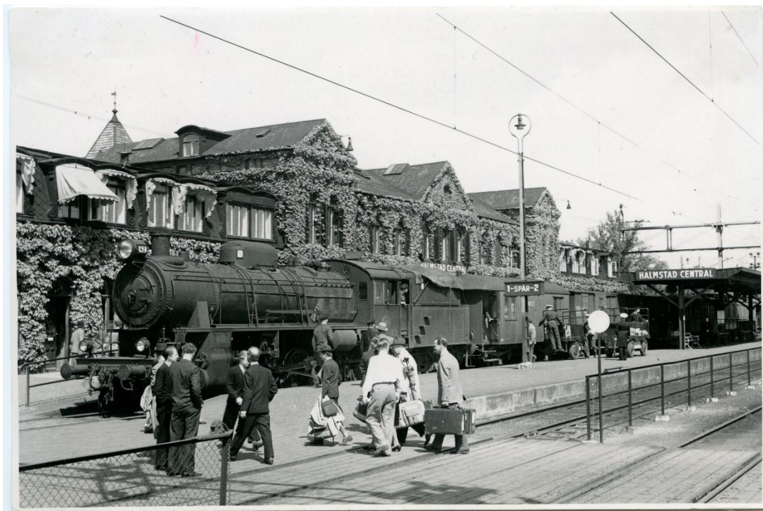
Figur B27. Halmstad station i juni 1945. Till höger i bild syns platta perrongtak med ett helt annat utförande än dagens som har sadeltak och böjda limträbalkar. Foto: Järnvägmuseet.
