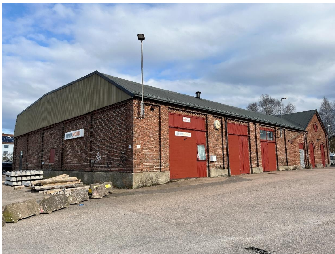
Figur B15. HBJ:s lokstall från sydväst. Lokstallet är tillbyggt i två omgångar. Först utfördes den mindre tillbyggnaden med sadeltak till höger i bild, därefter den större byggnadskroppen närmast i bild.
