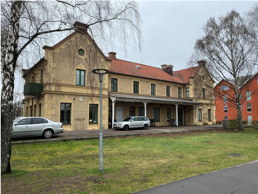
Figur B7. Halmstad – Bolmen järnvägs stationshus har kvar sin ursprungliga volym och en välbevarad tegel- och putsfasad. Det gamla skärmtaket mot spårområdet finns fortfarande kvar på den östra fasaden.
