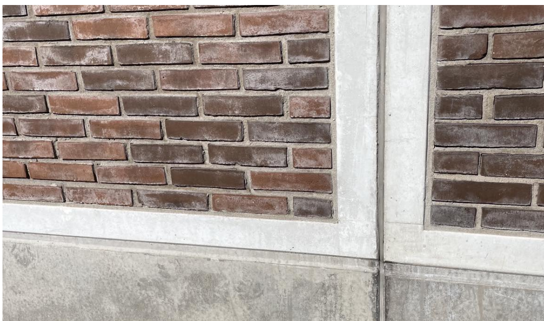
Figur 18 Exempel på tegel infällt i betongmur. (Bild TRV)
