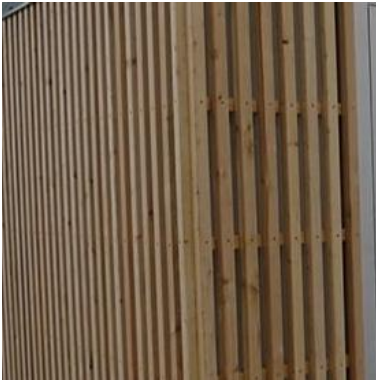
Figur 66 Exempel på träbeklädning/fasadbeklädning på teknikbyggnad, bild från https://boxmodul.com/sv/
