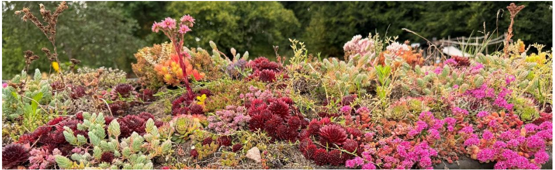
Figur 65 Exempel på sedumtak med stor variation.
