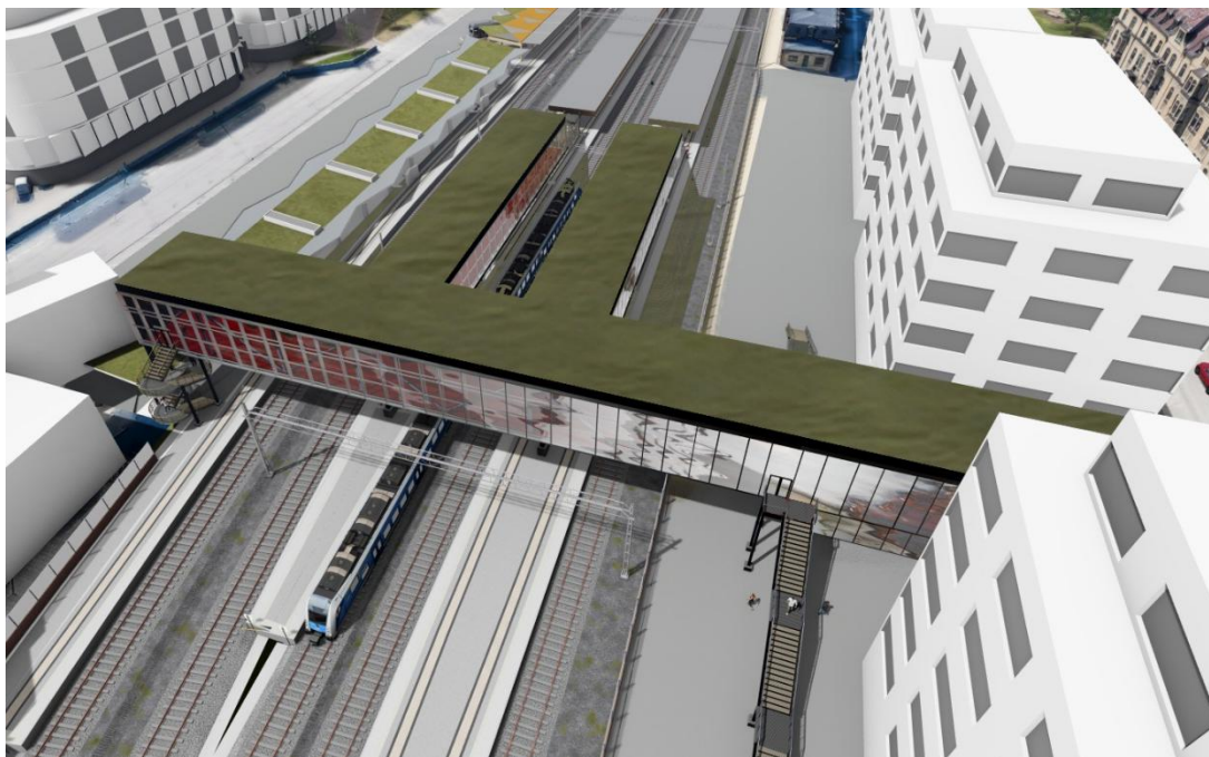
Figur 51 Vy över norra gångbron mot söder.
