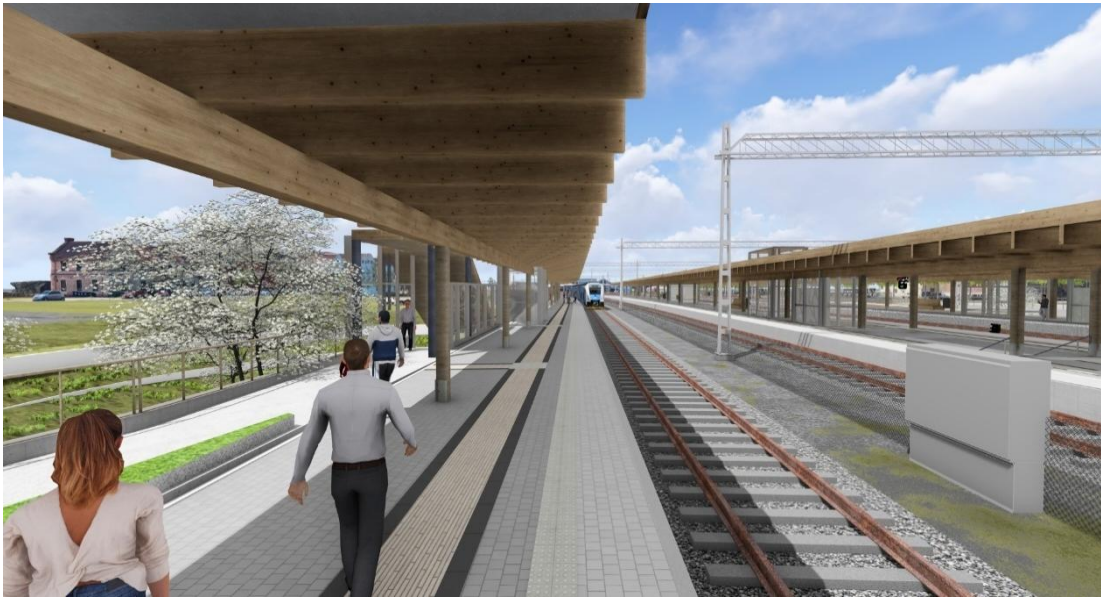
Figur 47 Plattformstak med KL-trä. Vy från plattform 3 mot söder.
