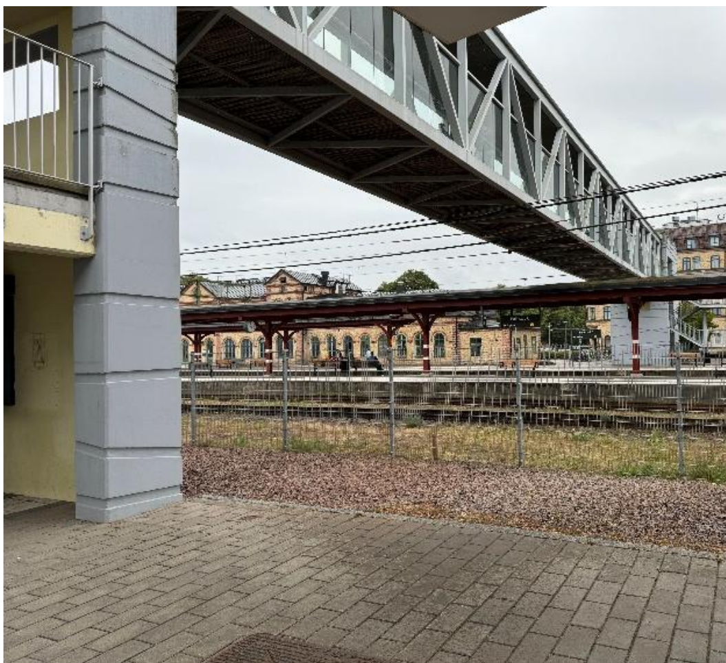
Figur 8 Befintlig gångbron över järnvägen, utan anslutning till plattformar.
