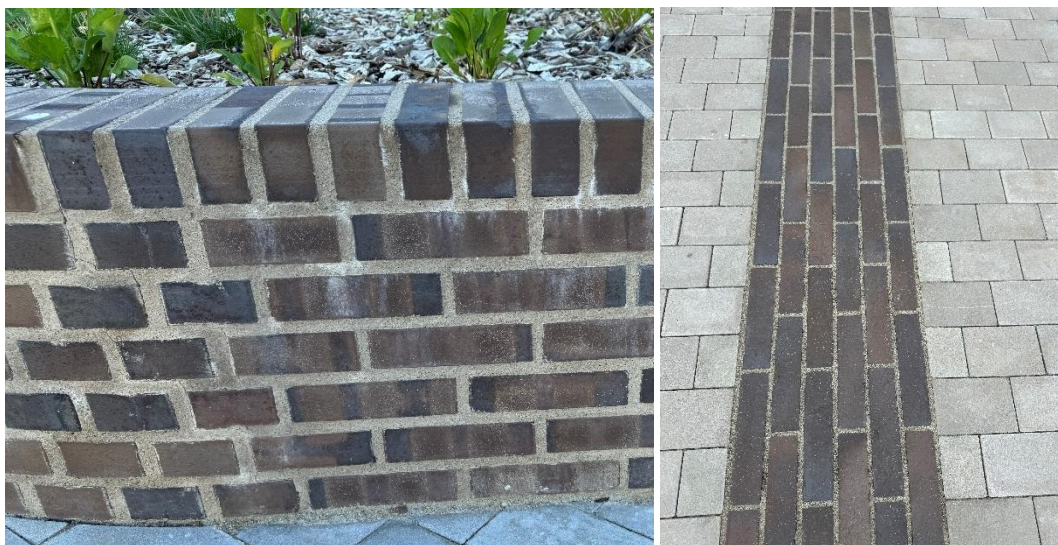
Figur 33 Exempel på tegelmur och markbeläggning med betongplattor och tegel.
