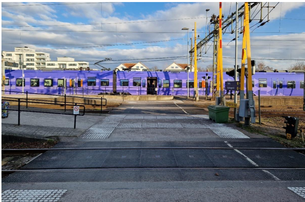
Figur 19 Befintlig plankorsning till plattformarna
