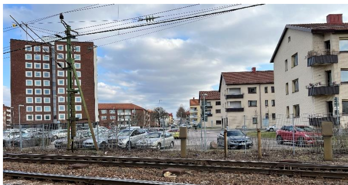
Figur 16 Bebyggelse längs Snöstorpsvägen öster om järnvägen.
