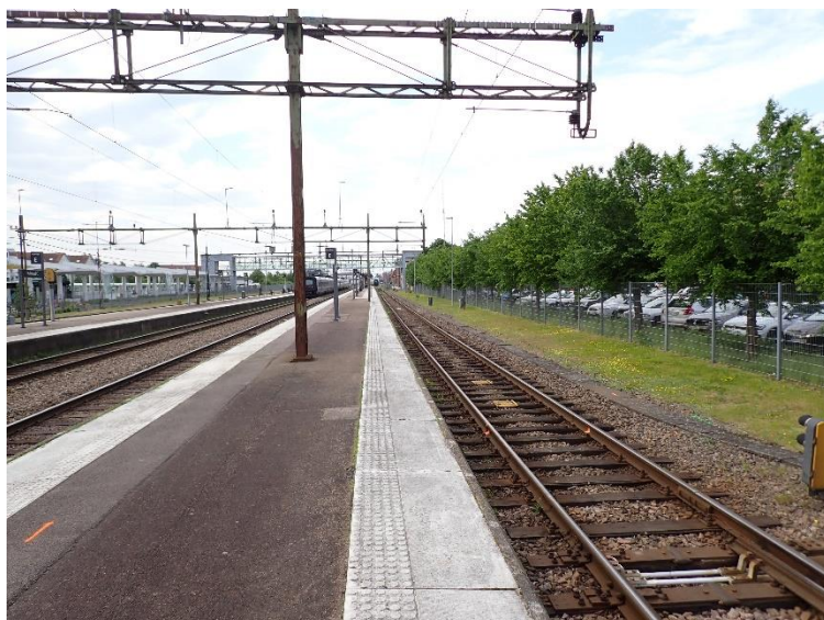
Figur 10. Plattform som är konstruerad av sidor (plattformsstöd) i betong. Ytbeläggningen består av betongplattor och asfalt.
