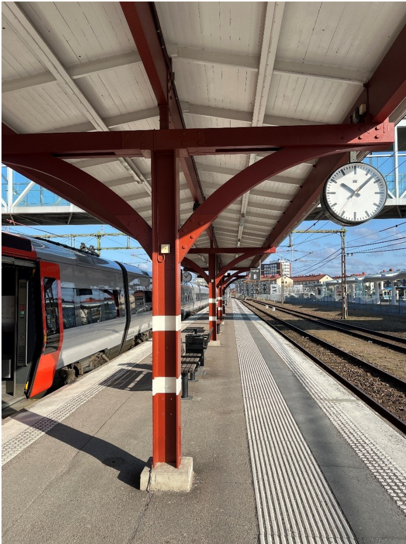
Figur B28. Plattformstaket vid spår 3 och 4 sett mot norr. Taken bärs upp av en limträkonstruktion monterad på stålbalkar. Plattformarna har moderna taktila stråk med vita plattor. Även bänkar, skyltar, avgångstavlor och papperskorgar är moderna. Plattformsområdet är generellt fattigt på äldre attribut.
