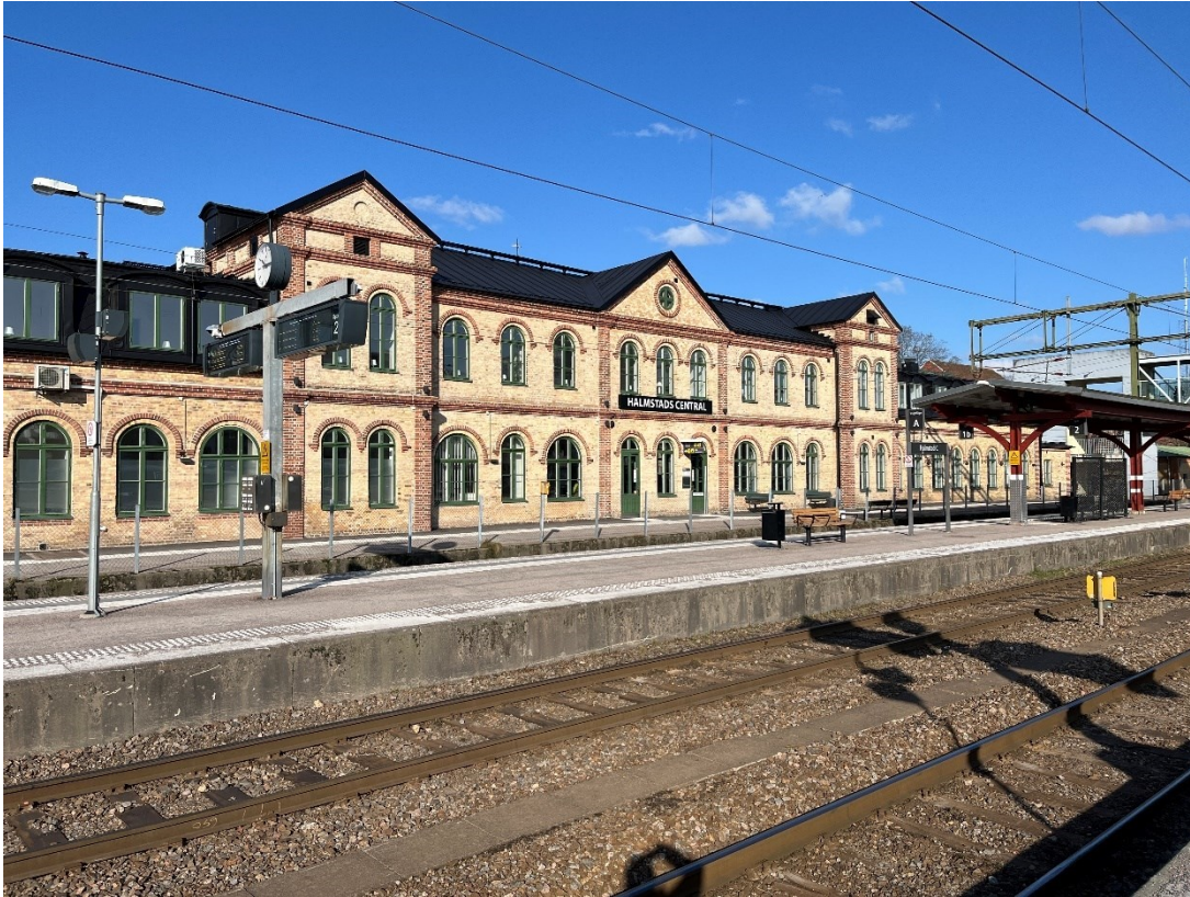
Figur B1. Stationshuset i stationshusområde A sett från södra delen av plattformen mellan spår 3 och 4. Jämför med Figur 9 ovan. Den ursprungliga högre delen av stationshuset syns mitt i bild flankerad av de senare tillbyggda lägre delarna mot norr och söder. Notera staketet som spärrar av plattformen närmast stationshuset mot spår 1. Det enkla Gunnebostängslet är som sina föregångare mycket genomsiktligt vilket gör att stationshusets fasad är enkel att se och uppleva för väntande och förbipasserande resenärer. Stationshuset upplevs som en del av stationsområdet.
