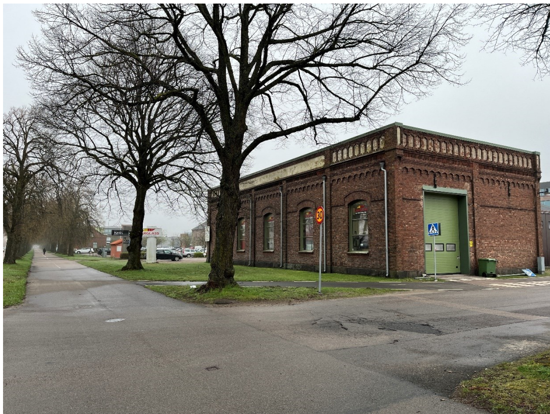
Figur B23. Ett parallellstall står närmast Järnvägsgatan i södra delen av området. Det tillsynes platta taket består av sågtak bakom de dekorativa putsade fälten överst på tegelfasaden. Byggnaden ska ha fungerat som både motorvagnsstell och måleriverkstad. Till vänster i bild, delvis dold av allén skymtar förrådsbyggnaden.
