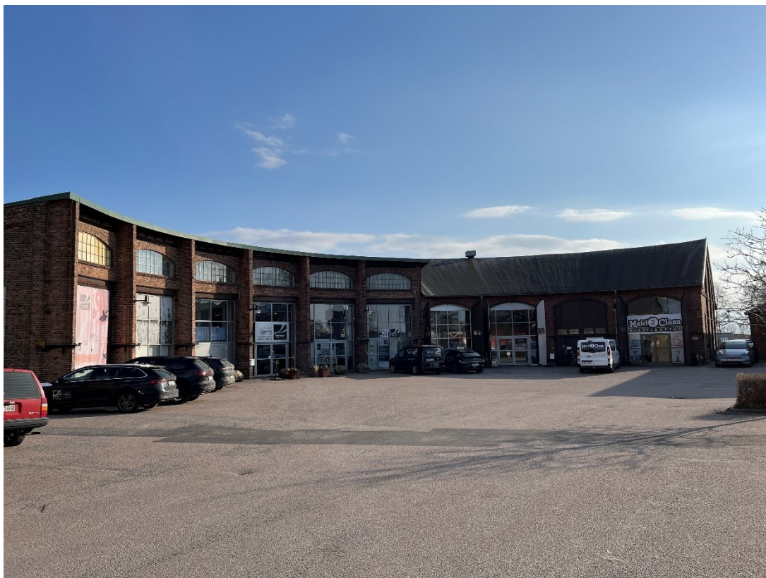
Figur B17. Strax intill lokstallet med 7 portar ligger det andra HNJ-lokstallet med 10 portar. Ovanför 6 av portarna finns äldre bågformade fönster med gjutjärnsspröjs. I övrigt är portar och fönster bytta på båda HNJ-lokstallen.
