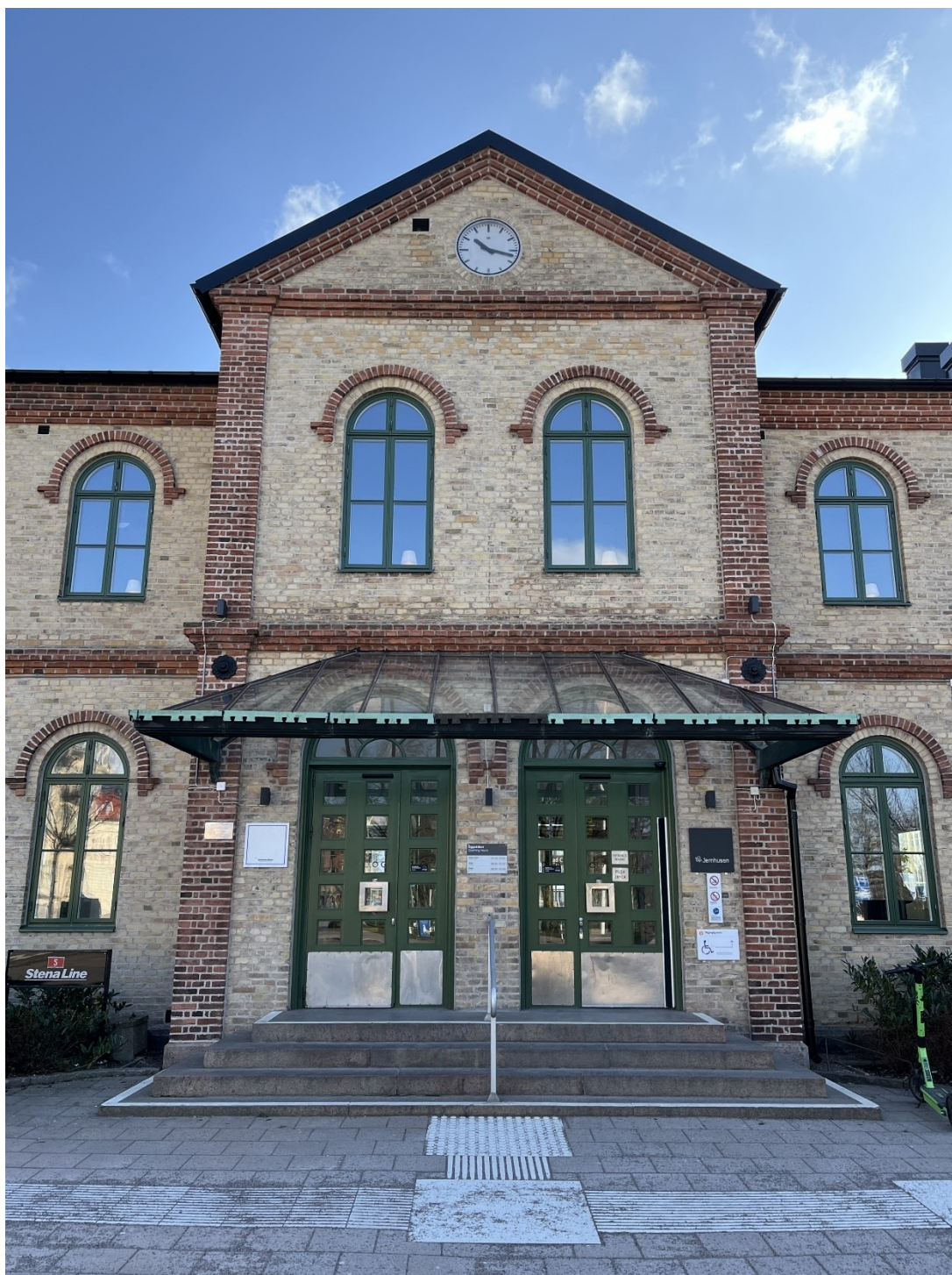
Figur B4. Stationshusets entréparti från Stationsgatan.
