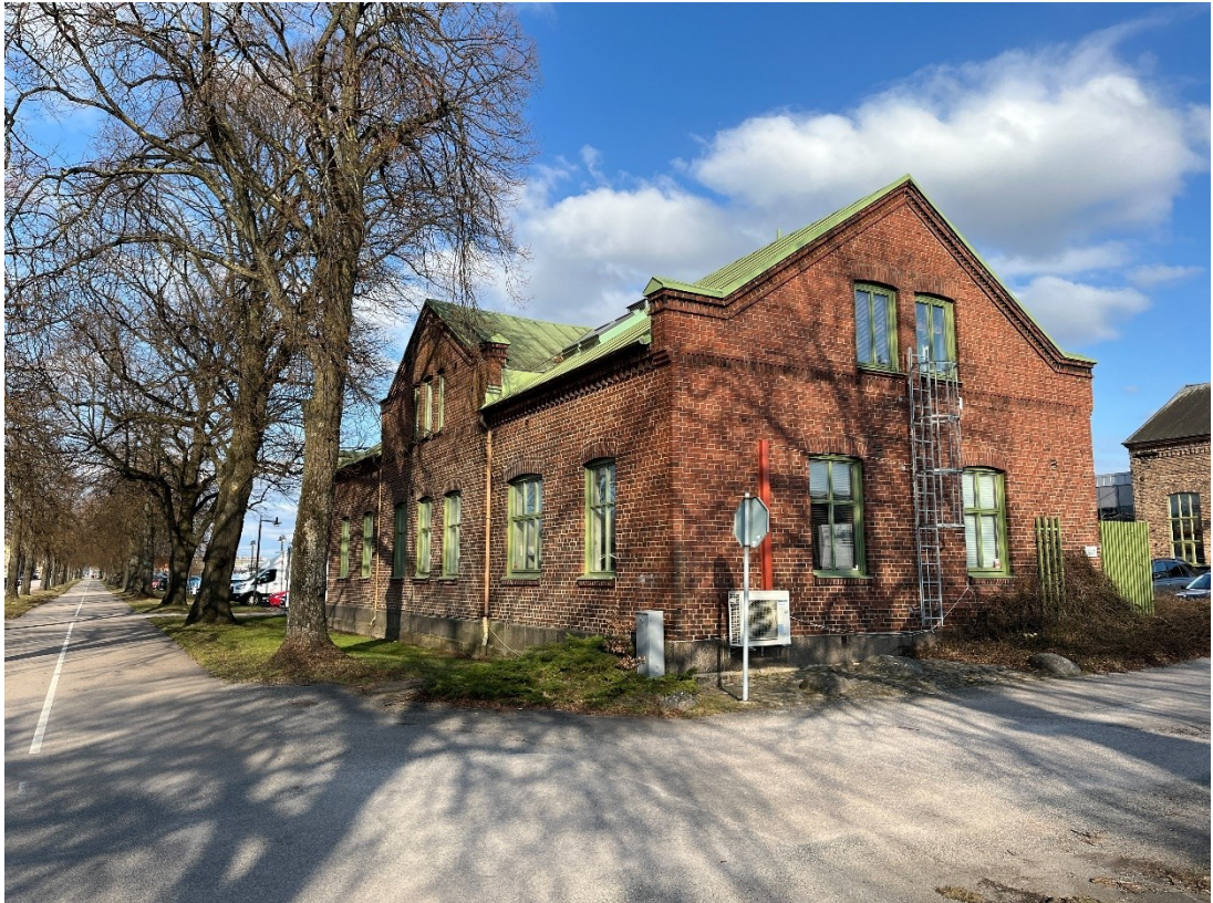
Figur B24. Längs allén som går söder ut från stationshuset längs Stationsvägen ligger denna friliggande tegelbyggnad i höjd med verkstadsbyggnaderna. Den benämns dels "förrådsbyggnad", dels "verkstadsbyggnad".
