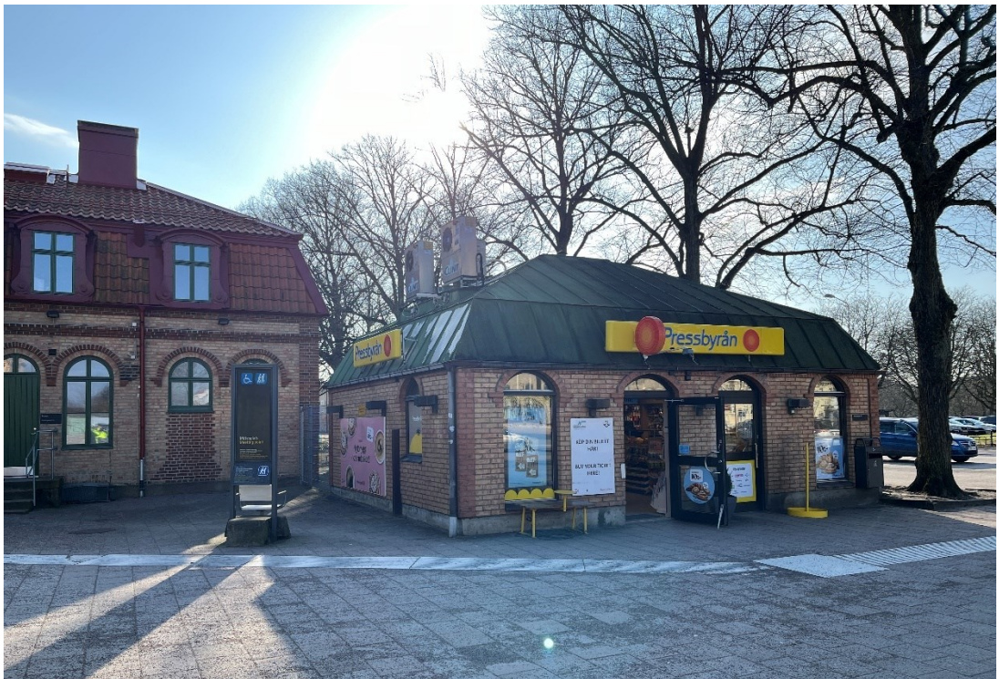
Figur B6. Pressbyråkioskens fasad och tak efterliknar såväl ilgodtsbyggnaden som stationshuset med liknande fasaduttryck och takutformning. En anpassning för att smälta in bland den äldre bebyggelsen.
