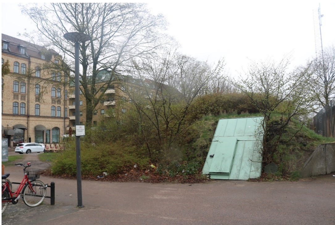
Figur B9. Norr om stationshuset finns en grönyta som bland annat består av denna kulle med nedgång till ett underjordiskt teknikrum.
