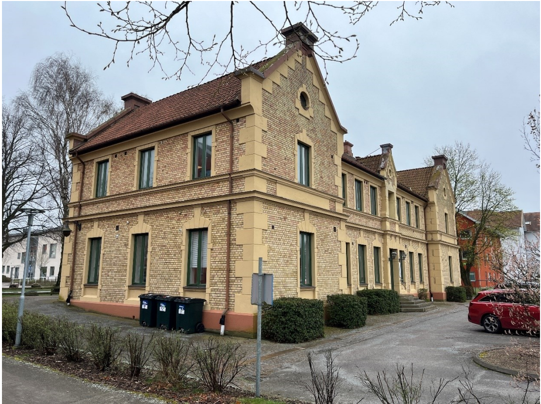
Figur B8. Byggnadens östra fasad som vetter mot dagens spårområde och Bolmensgatan.
