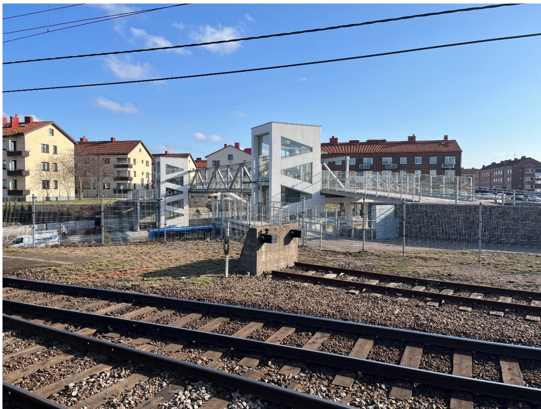
Figur B29. Stoppbock i betong med gummibuffertar.
