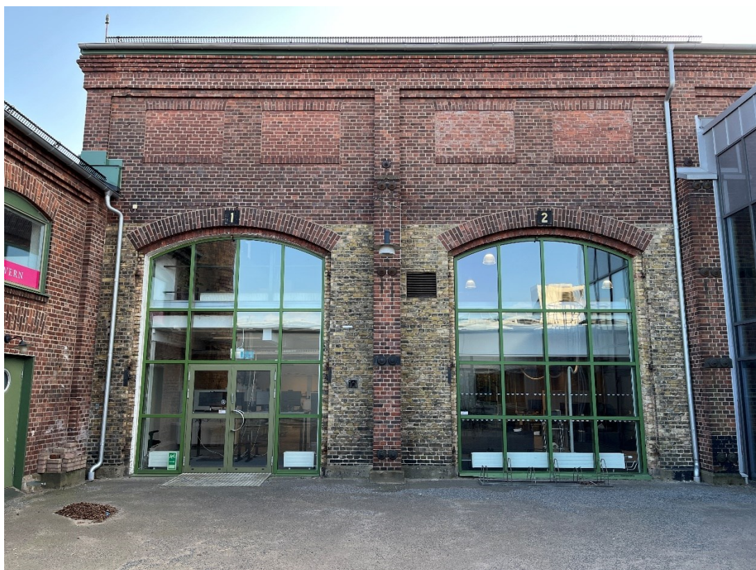
Figur B21. Del av norra fasaden på den södra verkstadsbyggnaden som i söder är sammanbyggd med ett av rundloksställen. Portarna har bytts ut mot glasade fasader.
