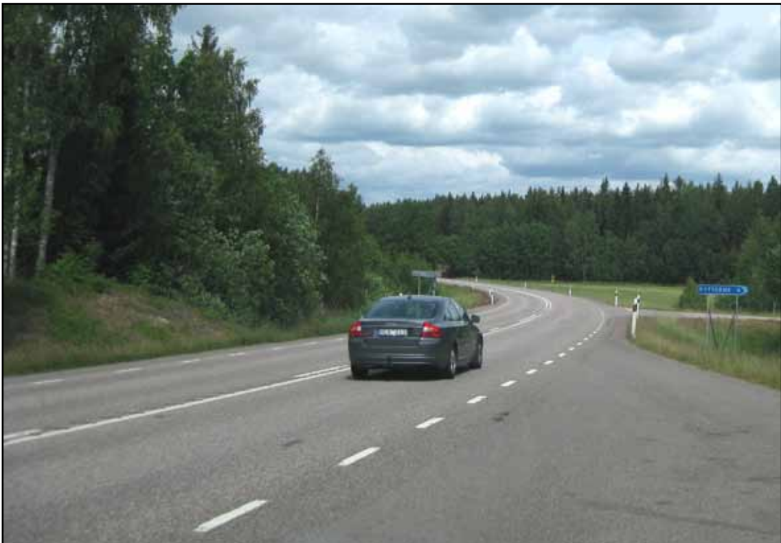
Figur 2.2 Den södra korsningen vid Gruffet (56/528), avfart mot Rytterne.
