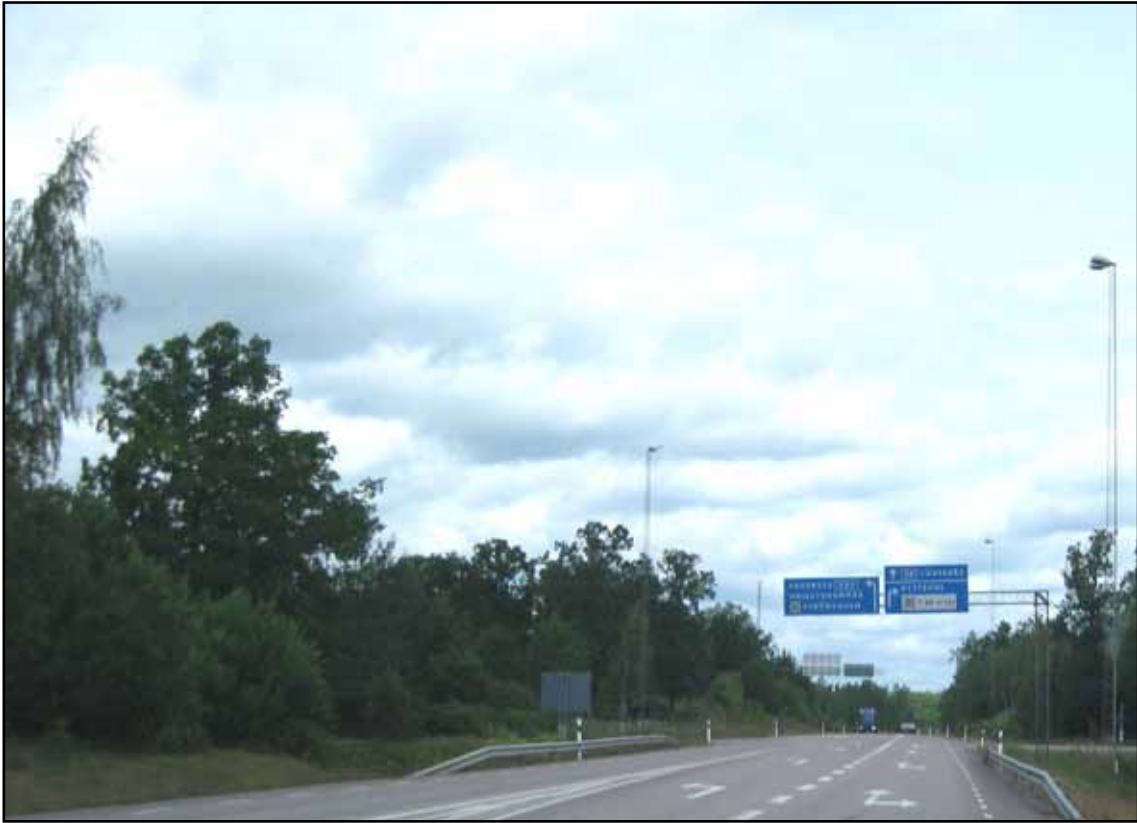
Figur 2.1 Rytternekorset (56/252/527), avfart mot Strömsholm (vänster) och Rytterne (höger).
