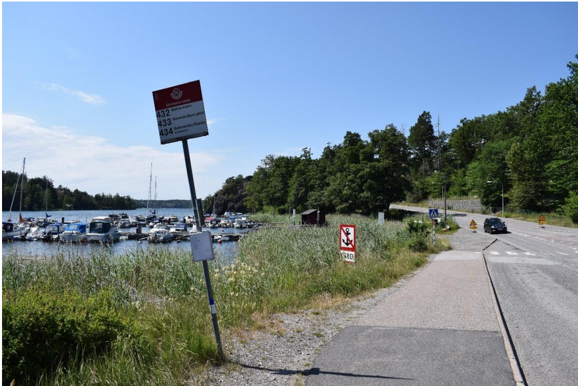
Figur 3. Hållplats Strömma kanal (41341) mot Sollenkroka med utblick mot väster. Foto: Loxia Group.
