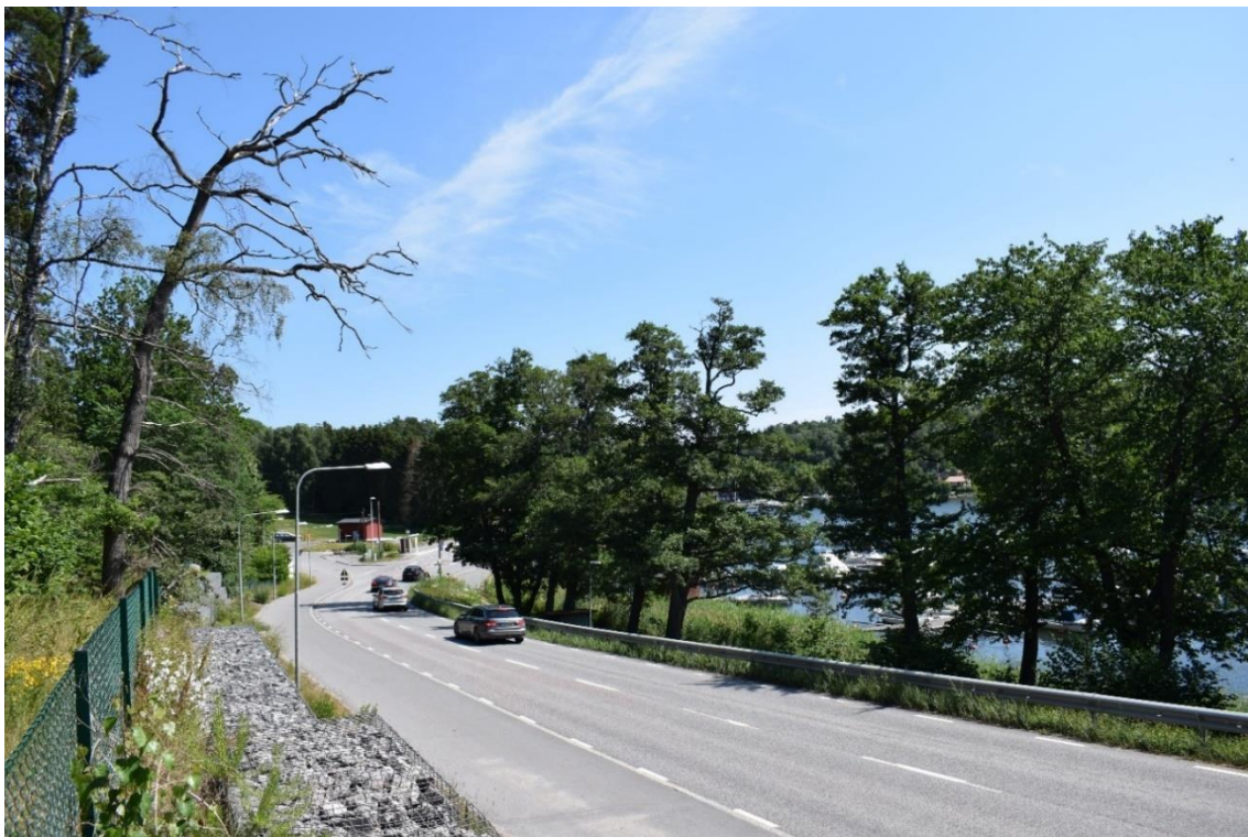
Figur 5. Begränsad sikt pga. träddridån längs med kurvan. Utblick från väster i körriktning mot hållplats Strömma kanal. Foto: Loxia Group.
