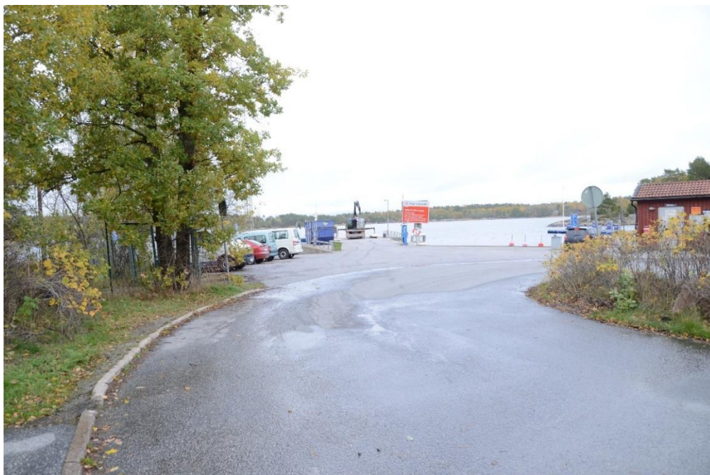
Fotografi 1. Befintlig vändslunga med sikt mot bryggan. Fotografi taget i riktning mot nordöst. Foto: Loxia Group.
