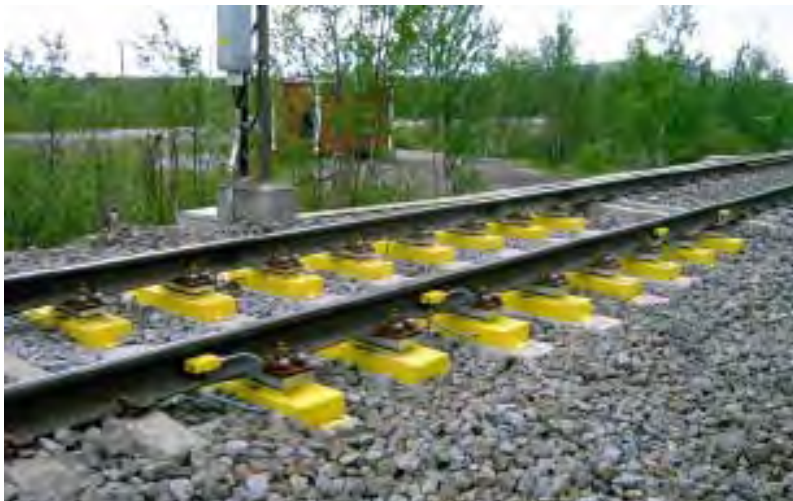
Figur 4: Varmgångsdetektorn mäter vertikalt underifrån mot den inre delen av lagerboxen. För manuell kontroll är dock vanligtvis endast det yttre lagerlocket åtkomlig
