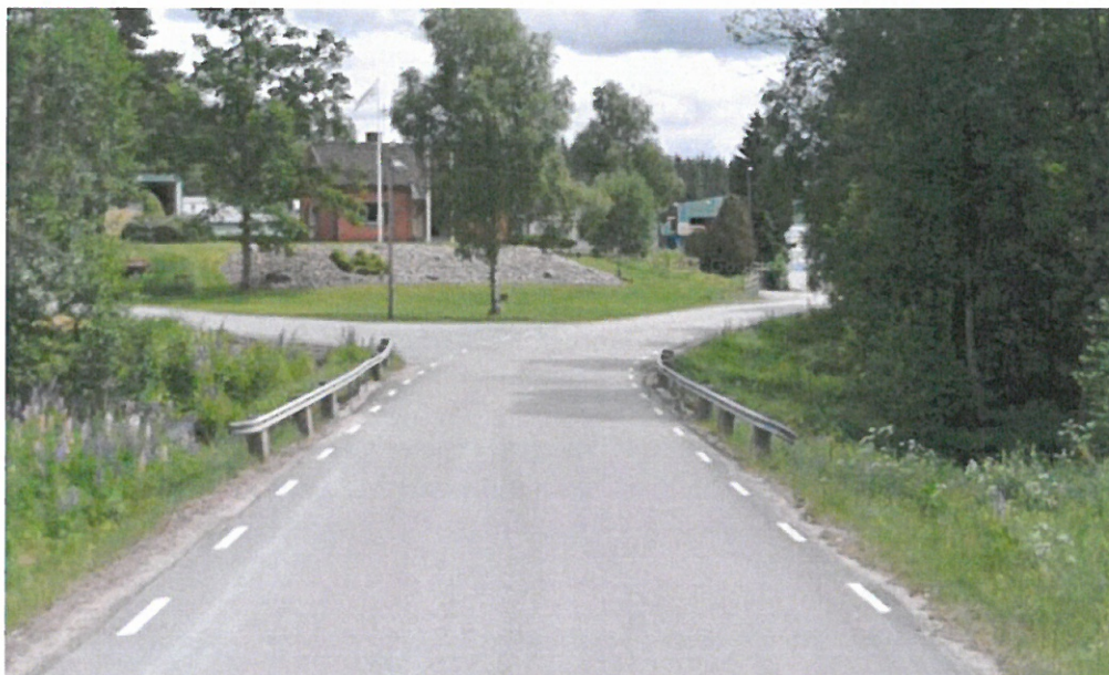
Figur 6. Bro på väg 1728, strax norr om sågverket, vy mot sydost. Utfarten från sågverket till vänster i bild, i direkt anslutning till bron. Foto: Google Maps.
