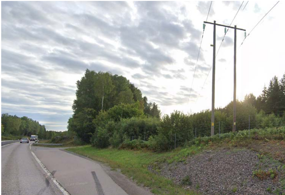
Figur 5.3.8:1 Höghspänningsledning vid ekodukt
