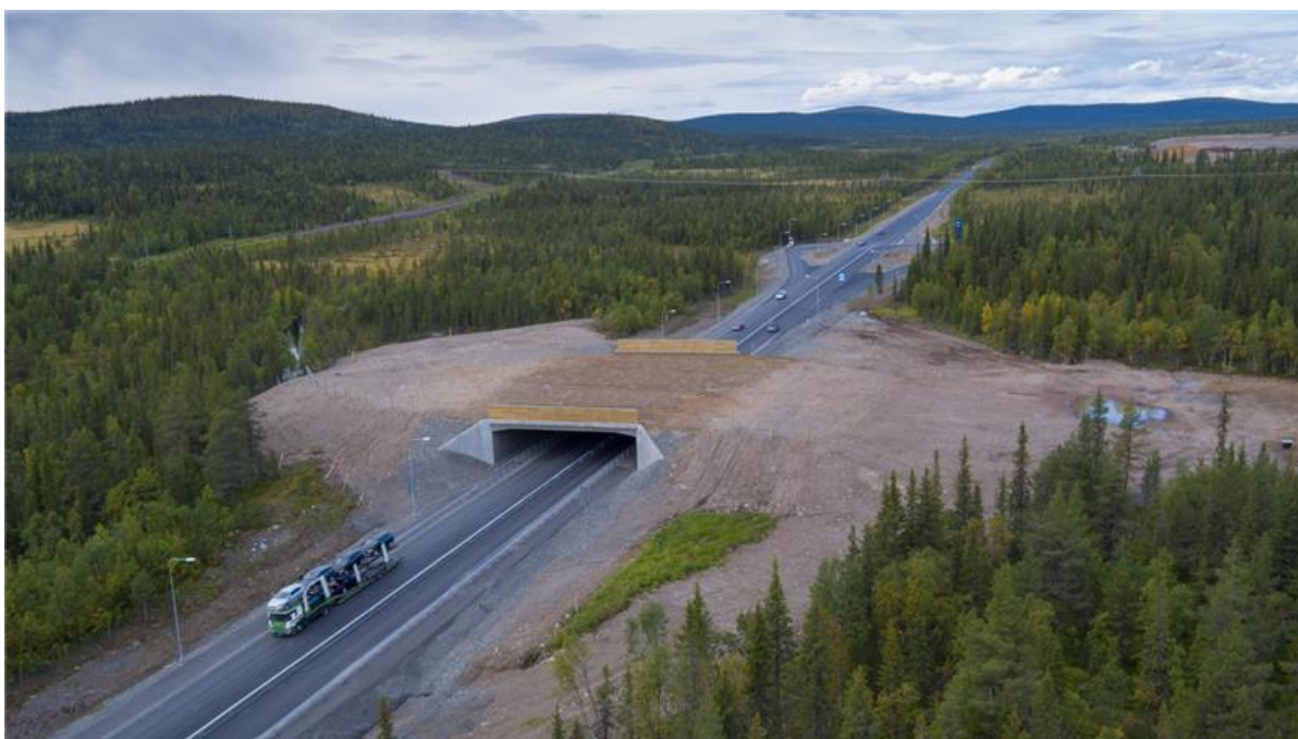
Figur 5.1–3 Exempel på planskild faunapassage. Bilden visar en faunabro över E10 Svappavaara (foto från BatMan).
