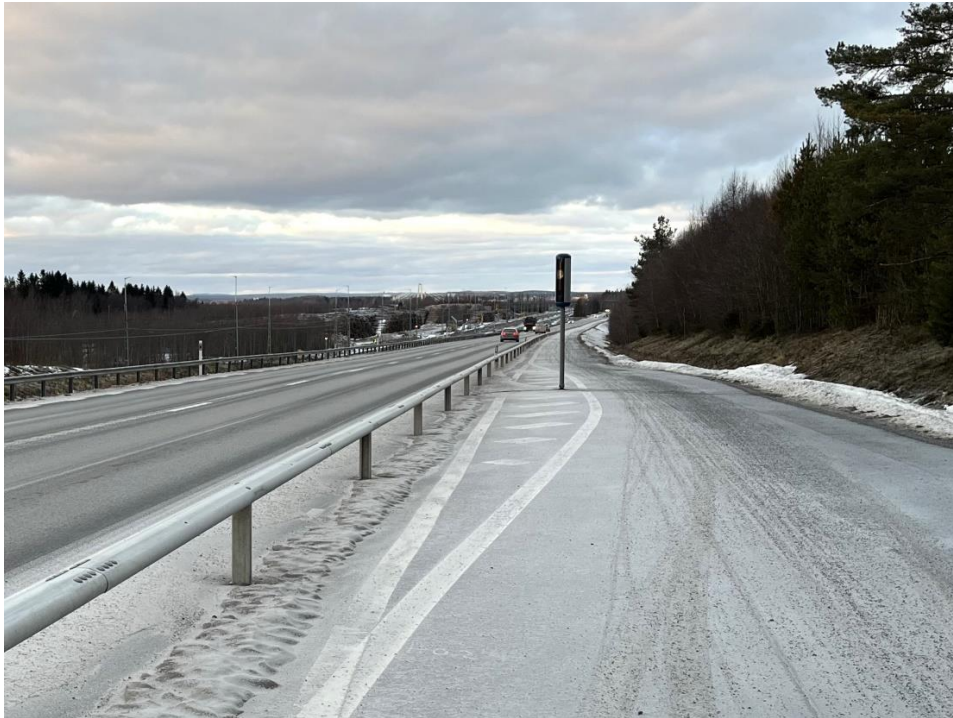
Figur 10. Exempel på passage av ATK för ny GC-väg mellan Holmsund-Umeå, färdigbyggd 2024.
