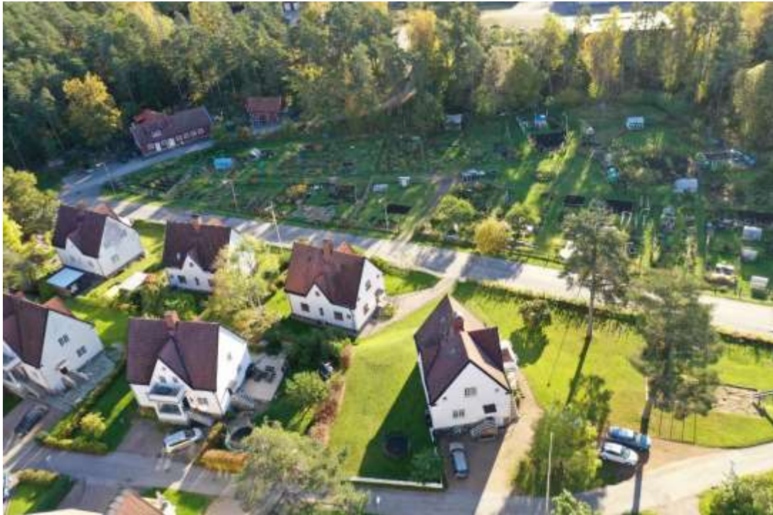
Figur 27. Byggnadsminnet Västergärdet. Bild: Tellur AB.
