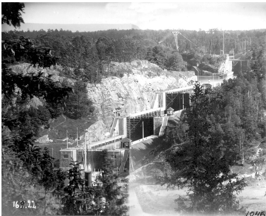
Figur 35. 1916 års slussar från Göta älv. Intill varje slussport finns en manöverhytt. Foto: Sjöfartsverket 1922.
