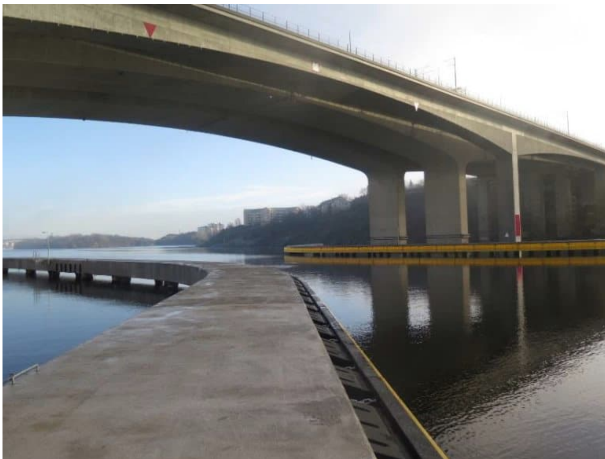
Figur 23. Gröndalsbrons ledverk och exempel på hur ledverken vid Essingebron skulle kunna utformas.
