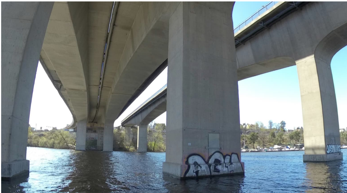
Figur 18. Direkt under Essingebron är landskapet redan starkt präglat av bronns storskaliga pelare, som på sina ställen blivit canvas för graffiti. Här är landskapets känslighet lägre för förläggning av de framtida kollisionsskyddens nya betongkonstruktion.
