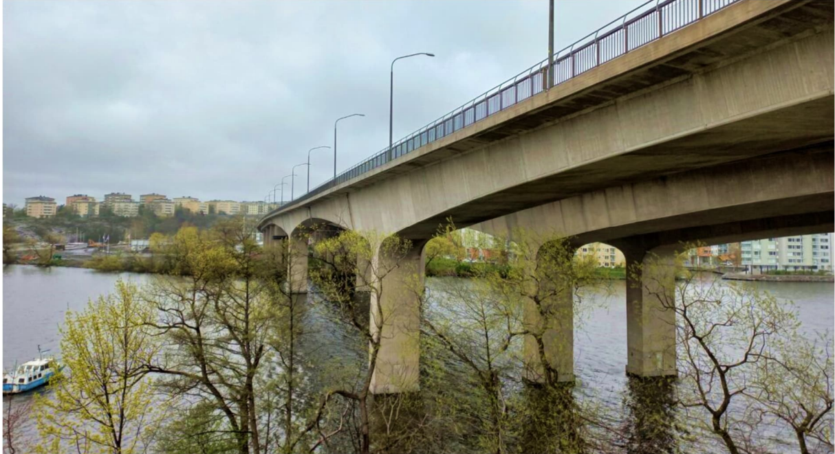
Figur 15. Upplevelsen av landskapets skala är olika för de som passerar med bil respektive med båt – eller cyklar och går till fots. För de som bor i närheten, kan bron utgöra ett karaktärsskapande landskapselement och landmärke i vardagslandskapet. I fonden - bostadsområden i varma kulörer på Stora Essingen.
