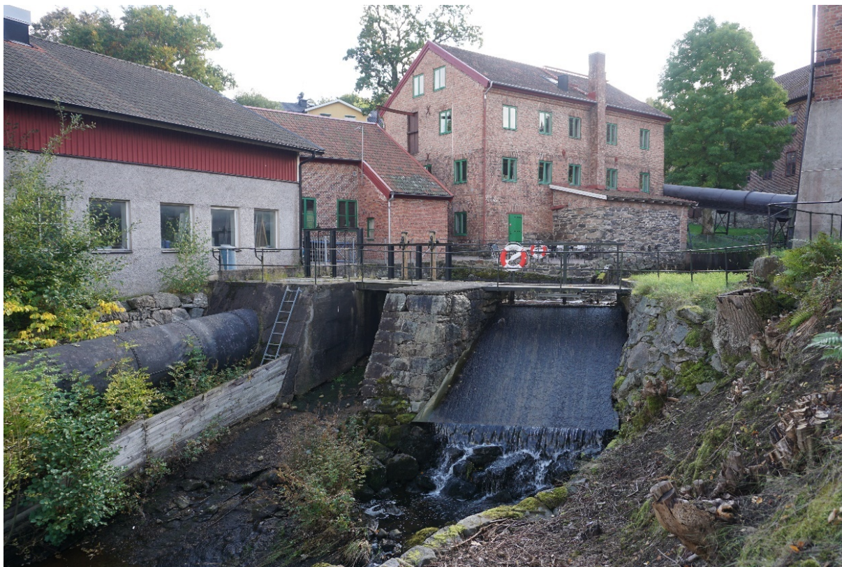
Figur 19. Kulturhistoriskt värdefull bebyggelse inom Tollered trafikplats. Byggnaderna har tidigare tillhört Nääs fabriker. Byggnaden till vänster är idag museum och till höger i bild ses delar av Tollereds kraftverk och tub.
