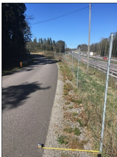
Figur 23: Från söder, smal sektion mellan gång- och cykelvägen och E20 vid Offerkastet.
