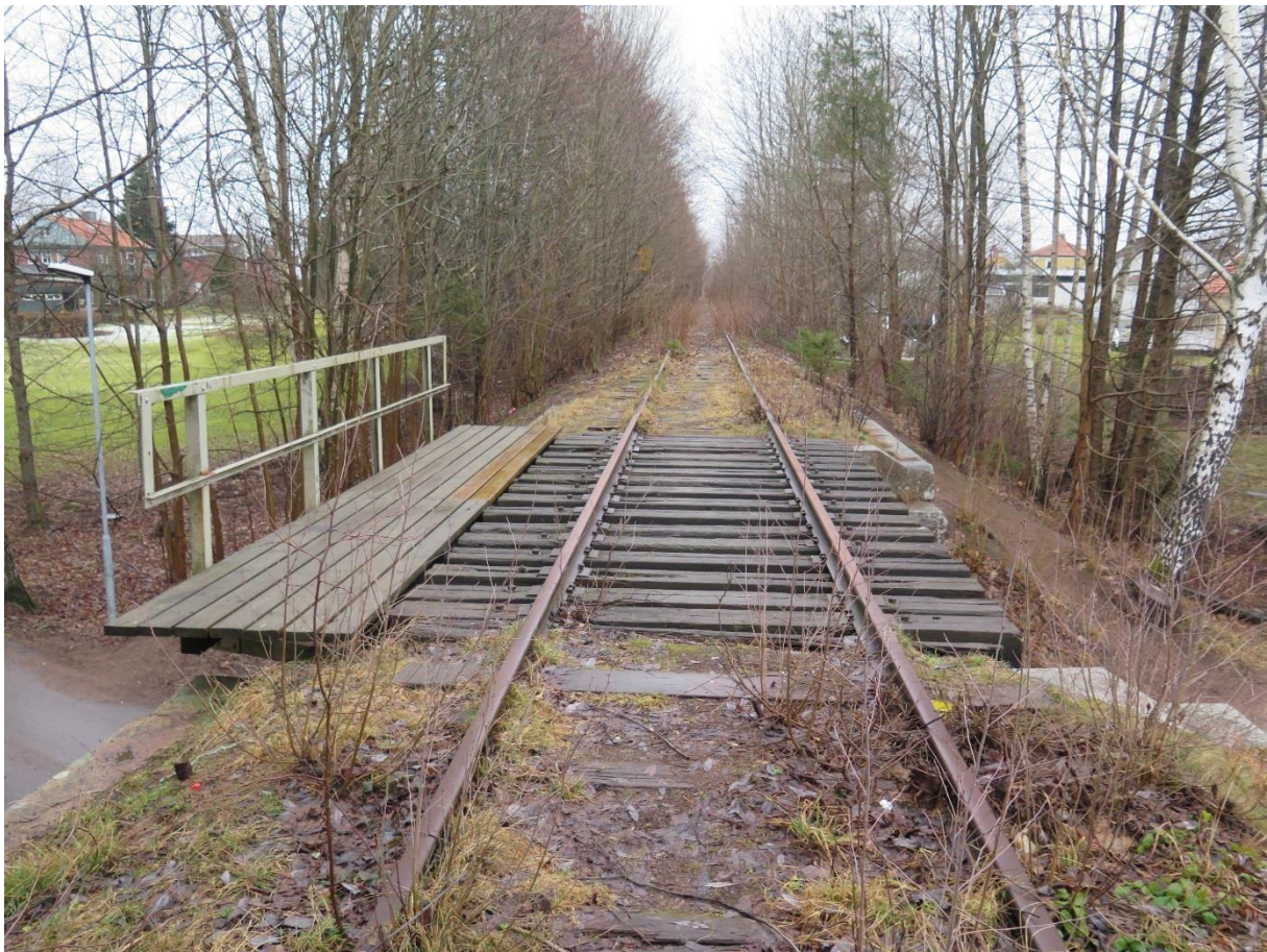
Tibro Balteryd. Objekt 51, bro över Tidån. Fritt upplagd balkbro. Längd 47,5 meter.
