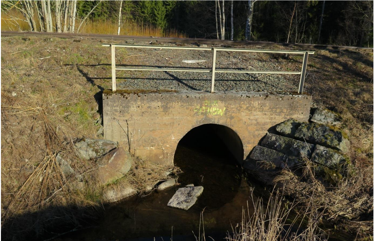
Kulvert i betong med en mindre stödmur i natursten.
