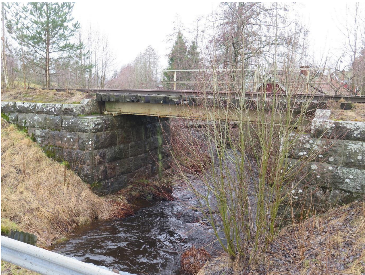
Tibro. Objekt 50, vägport samt bäck i kulvert. Fritt upplagd balkbro. Längd 5,5 meter.
