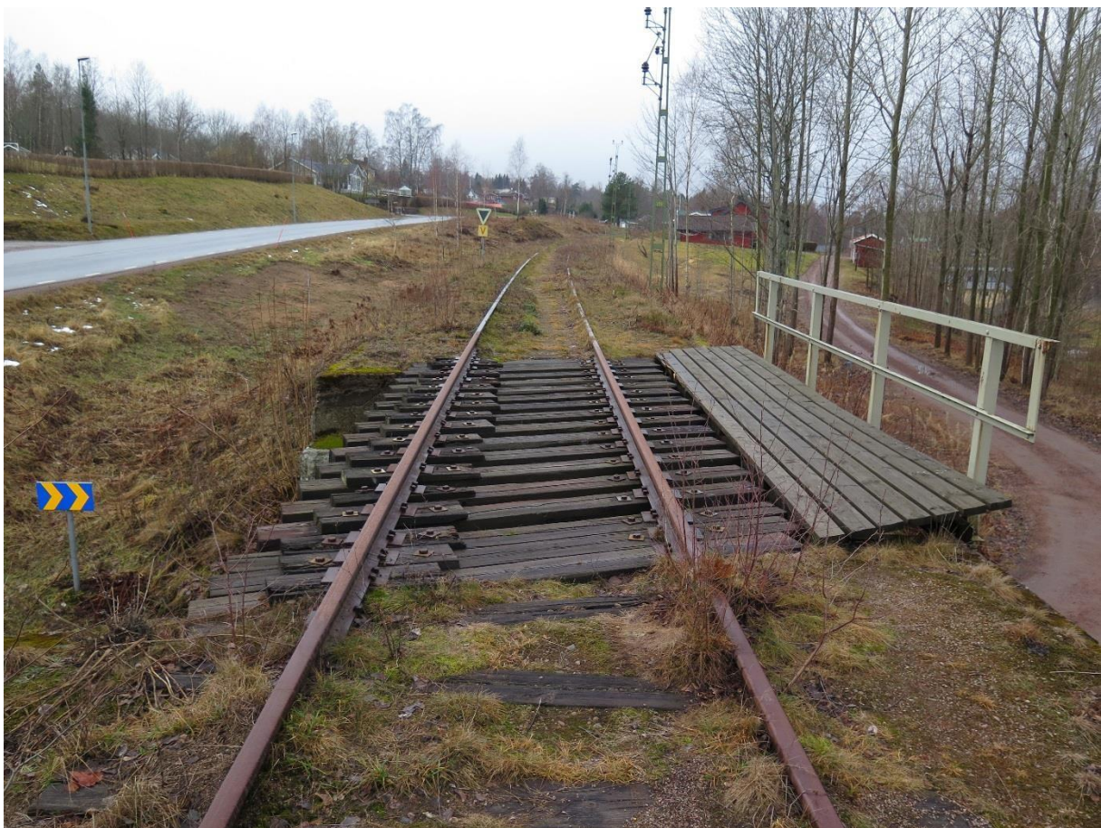
Karlshaga by. Objekt 41, vägport. Fritt upplagd balkbro. Längd 3,7 meter.
