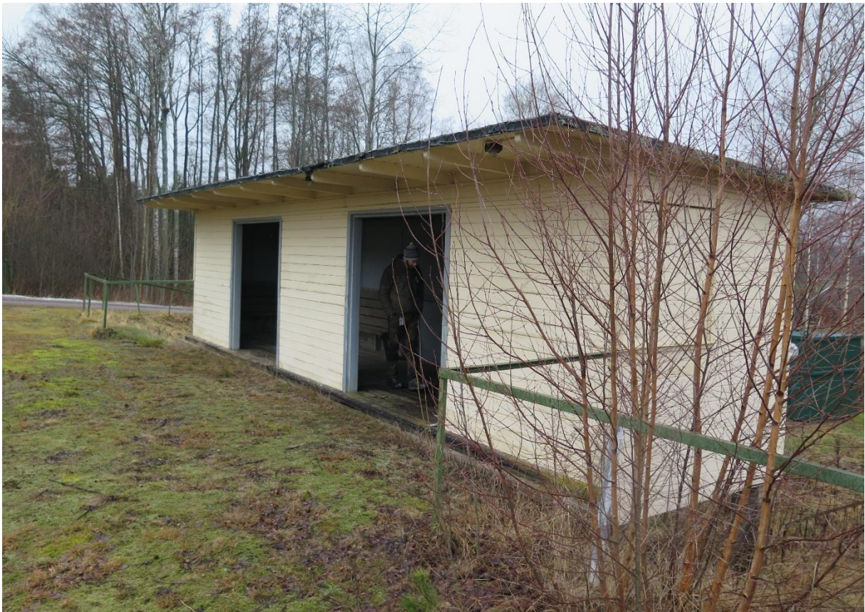
Foto från öster. Notera det grönmålade staketet.
