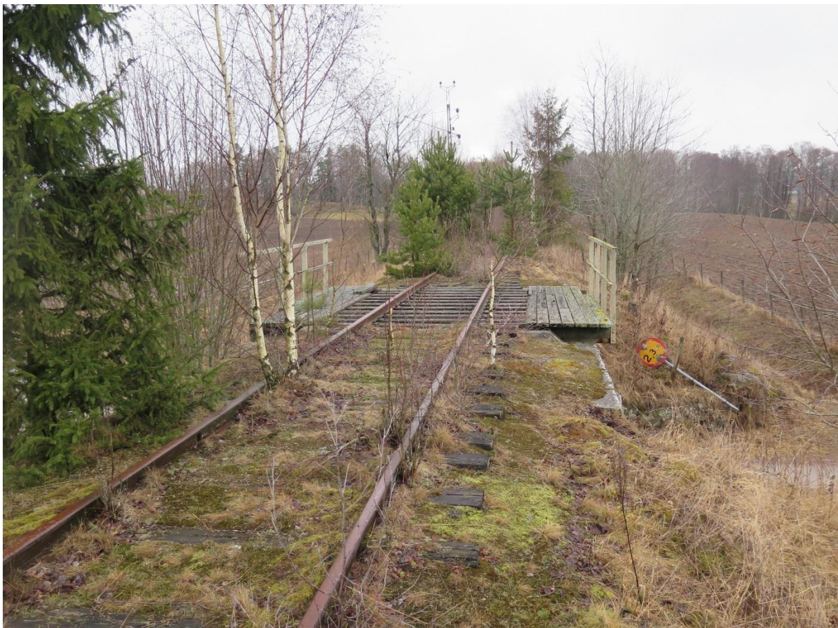
Anderstorp. Objekt 47, bro över Gärebäcken. Fritt upplagd balkbro. Längd 5,9 meter.
