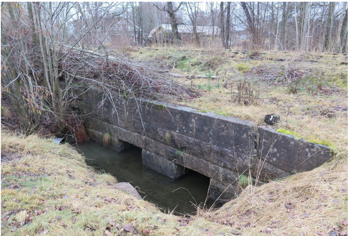
Kulverten i huggen sten strax väster om stationen.
