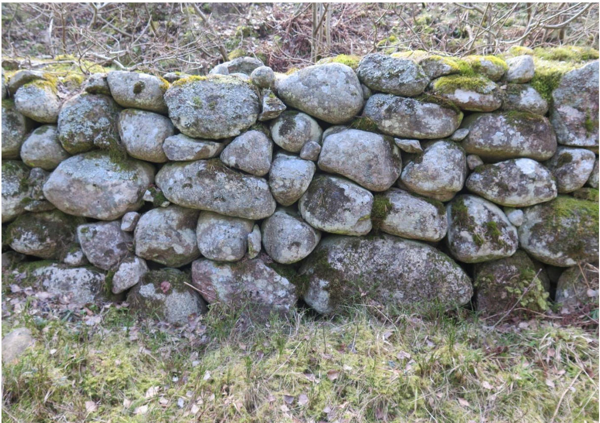
Exempel på stenmur vid Marhultsby. Här är stenen mer naturligt rundad i formerna.
