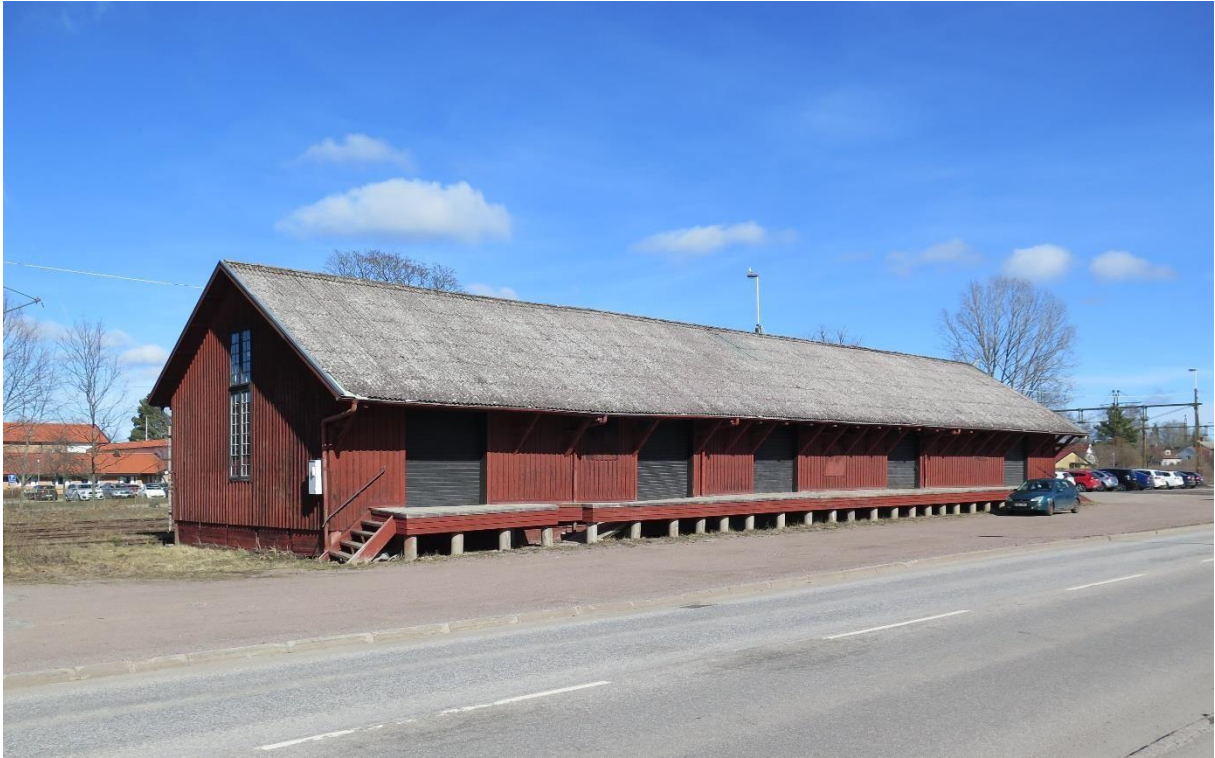
Foto från sydväst. Längs hela södra långsidan sträcker sig en lastbrygga. Godsmagasinet är ett välbevarat exempel på de godsmagasin som finns eller en gång har funnits utmed våra järnvägar. En viktig mötesplats för näringslivet när det var dags att frakta sina produkter eller för privatpersoner när det var dags att använda järnvägen för att skicka presenter till avlägsna släktingar.
