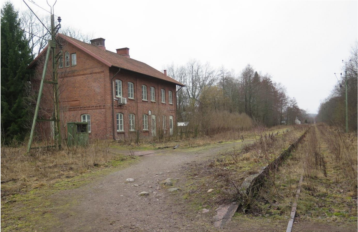
Perrongen finns kvar utmed spåret. Foto från nordost.
