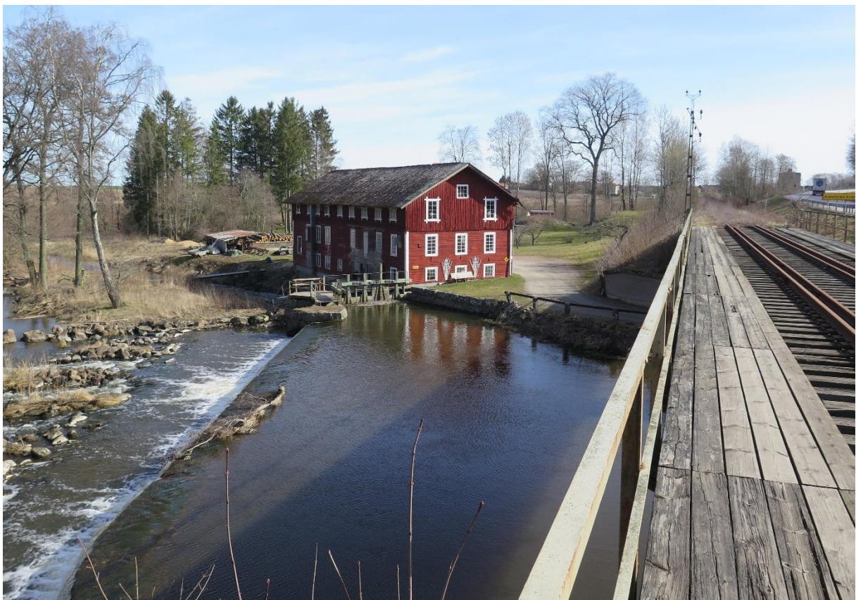
5.3.11. Skyltar, signaler och kulvertar
