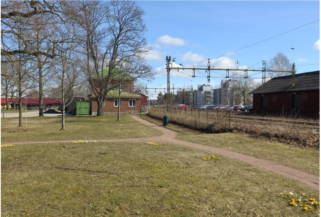
Foto från väster. Järnvägsparken med stationshuset rakt fram och godsmagasinet till höger.
