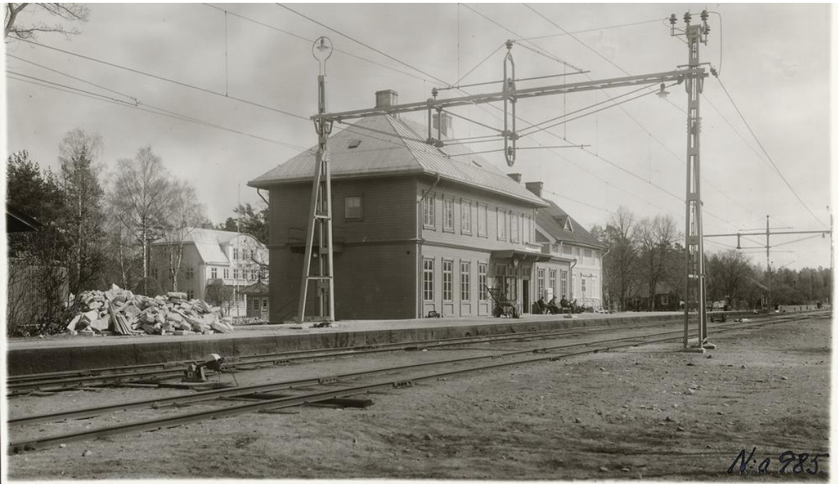
Karlsborgs station 1942. Fotot är taget 77 år tidigare än det förra från 2019. Samtliga byggnader på detta foto är idag rivna utom stationshuset. Det som saknas på fotot är den lilla boden med tälttak på norra sidan som alltså bör ha tillkommit efter 1942. Foto Samlingsportalen: Jvm KDAE04690:1942
