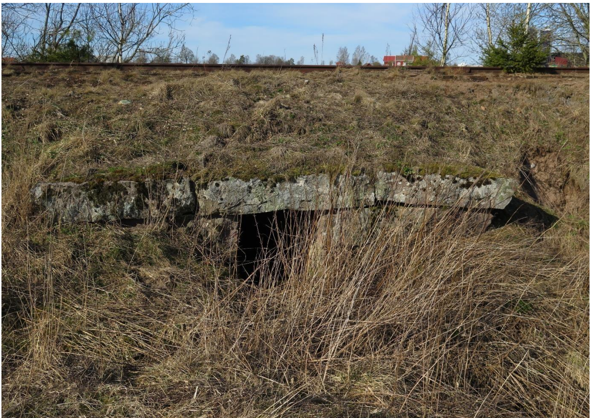
Exempel på kulvert under järnvägen för mindre vattendrag.
