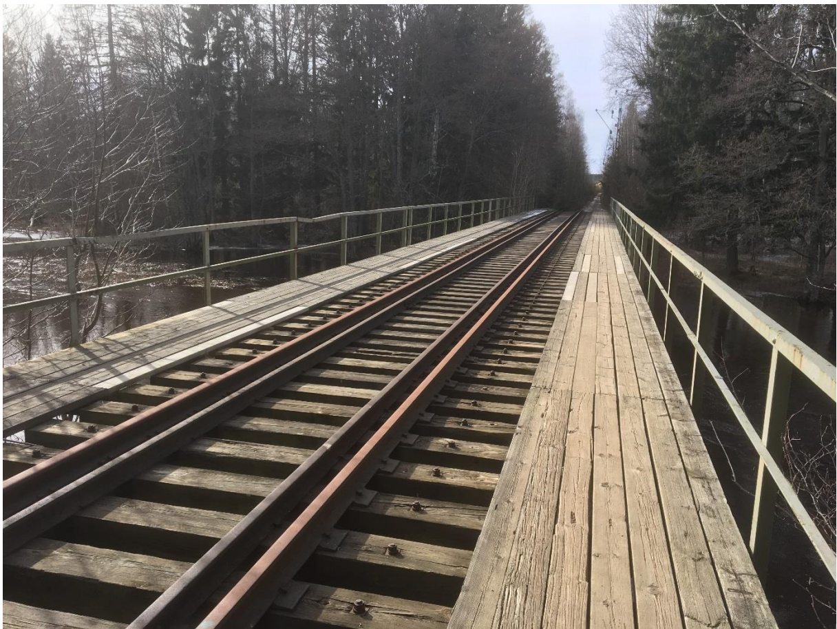
Asketorps kvarn. Objekt 76, bro över Ösan. Fritt upplagd balkbro. Längd 41,8 meter.
