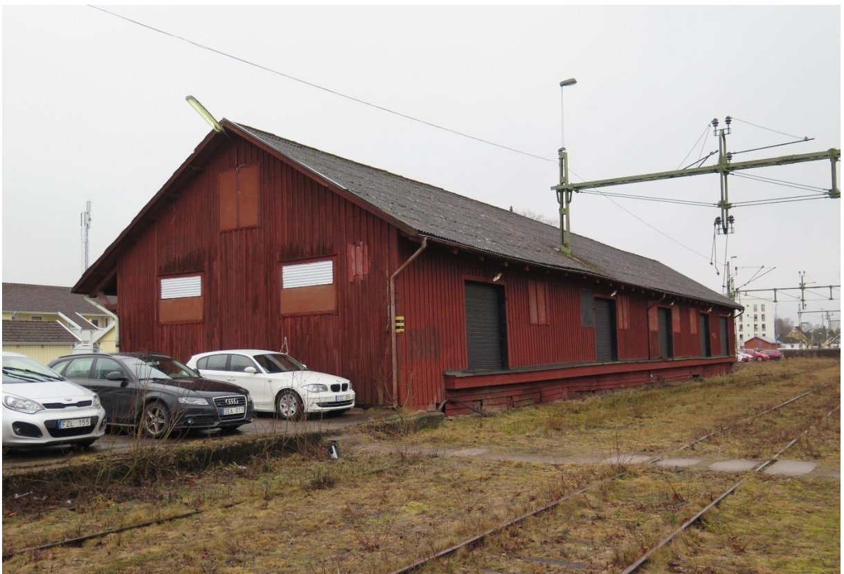
Foto från nordost. Godsmagasinet är välbevarat och används än idag för olika verksamheter. Notera kontaktledningsstolpens placering genom taket.
