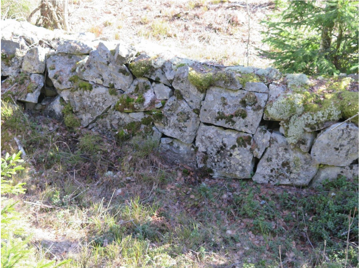
Exempel på stenmur vid Mölltorps grusgrop. Den övervägande delen av stenen är här av kantig utformning.
