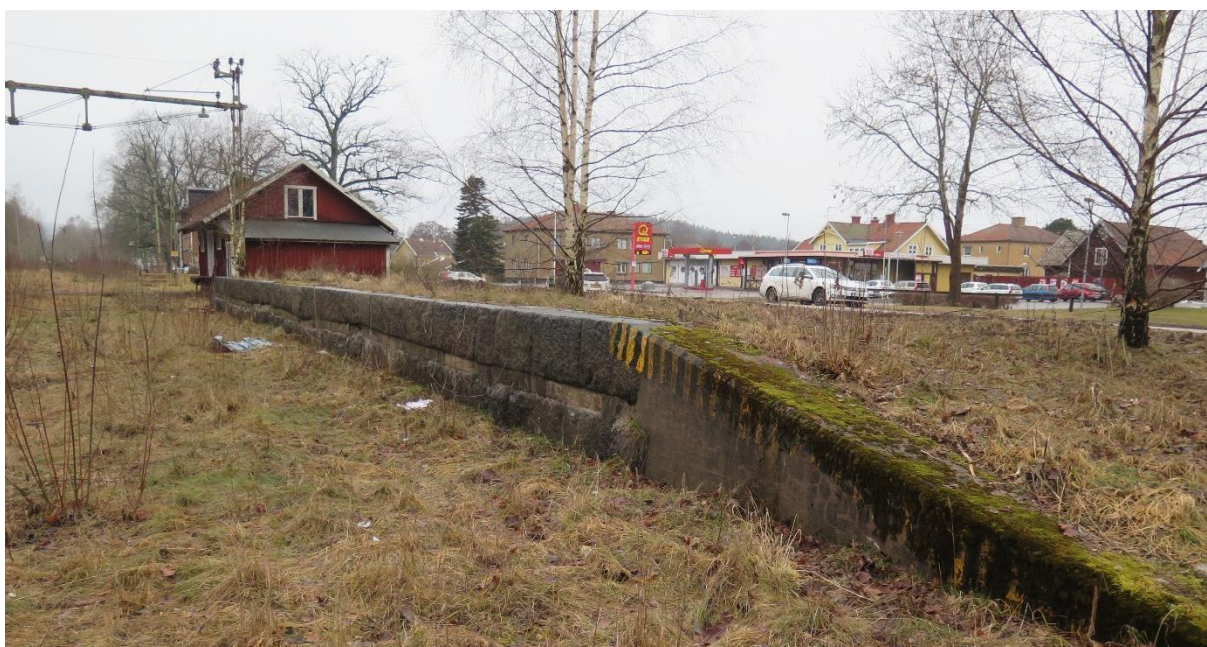
Lastkajen är i gott skick. Foto från öster. En av de bäst bevarade lastkajerna utmed Karlsborgsbanan.
