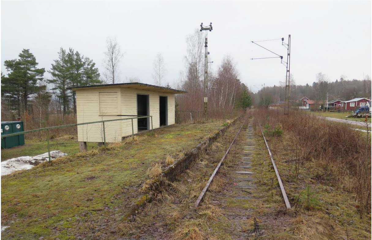
Örlebadets hållplats från väster. Notera den långa perrongen som sträcker sig långt in i växtligheten.
