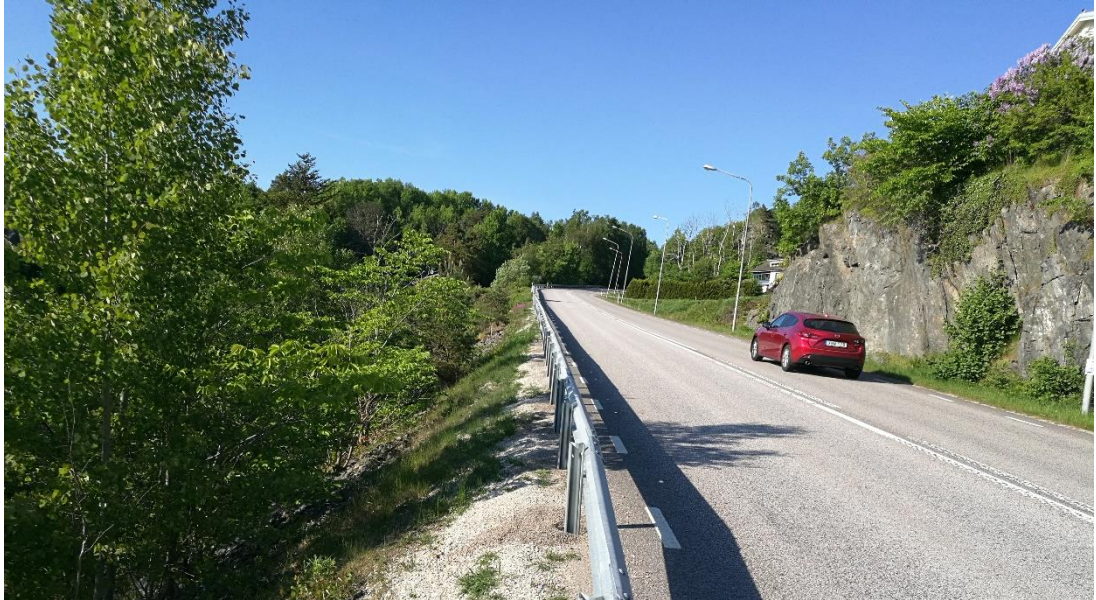
Figur 7. Väg 160 kantas på flera håll av branta bergsslänter. Till höger skimtar en villabostad ovanför bergsslänten. Bild tagen åt norr.
