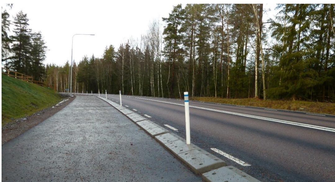
Figur 22. Pollare med reflexer används vid GCM-stöd för att markera trafiksepareringen och öka trafiksäkerheten.
