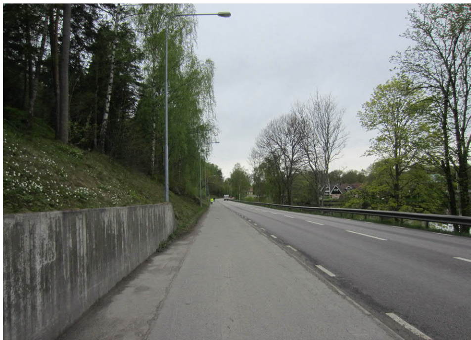
Bild 30. Vegetationsbeklädd slänt och stödmur av betong vid Nackaberget.
