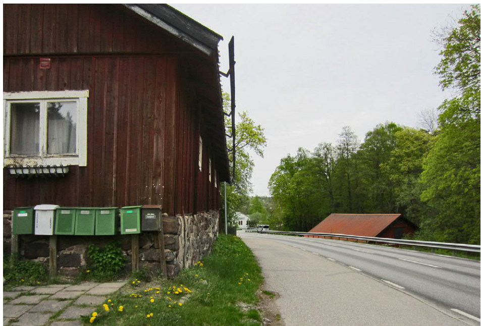
Bild 18. Ladugården, Vällingklockan, vid Nacka gård, km 7/300 ligger precis i befintlig vägkant. Öster om Ältavägen sluttar marken brant, vilket begränsar vägrummet.
