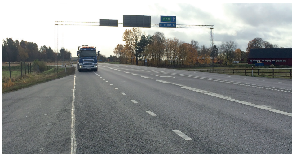
Bild 2. E 20 är 13 meter bred på stora delar men extra bred vid de större väggorsningarna.
