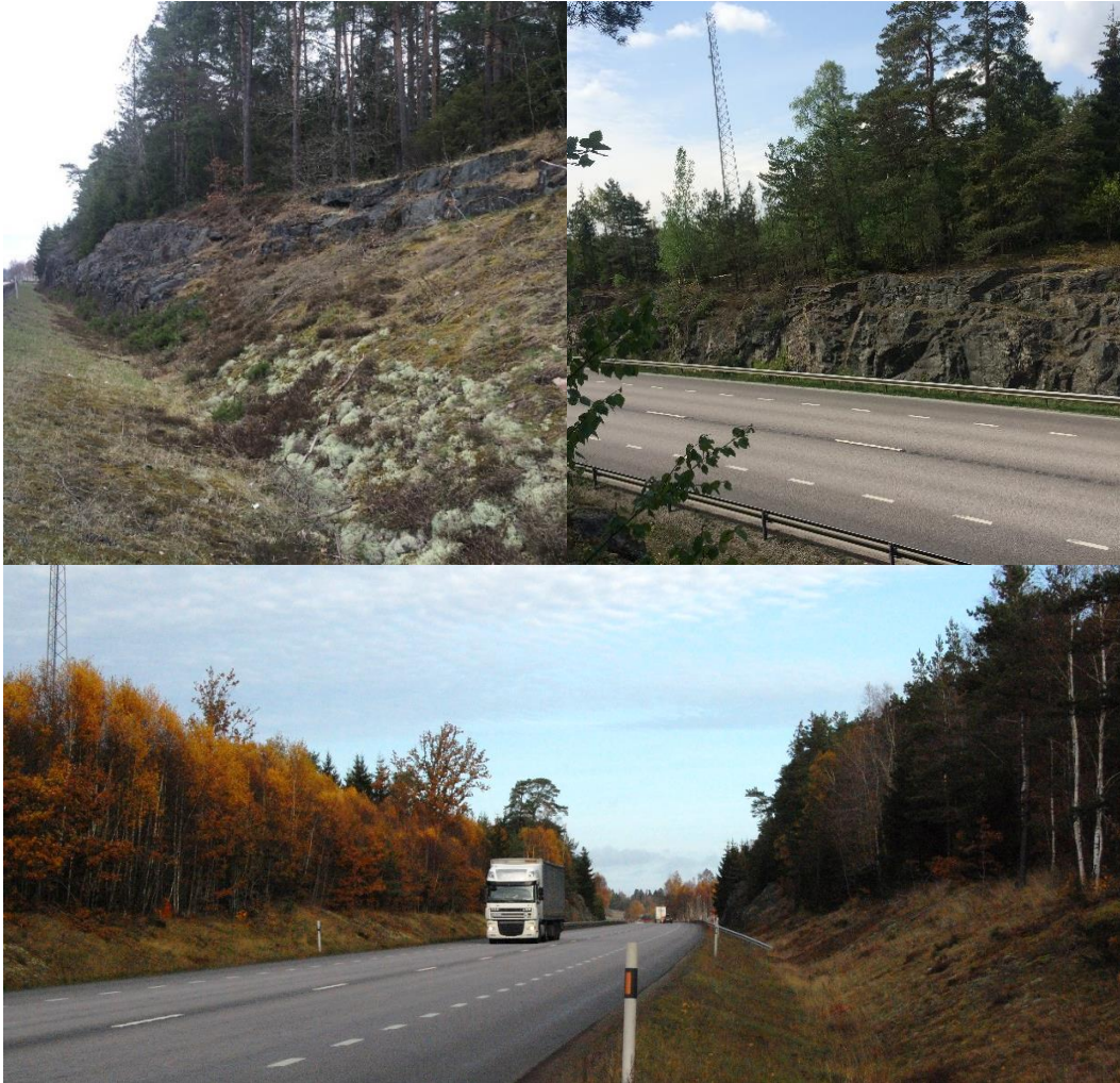
Figur 4.5:4. I den södra delen av sträckan går E20 genom en bergsskäring.
