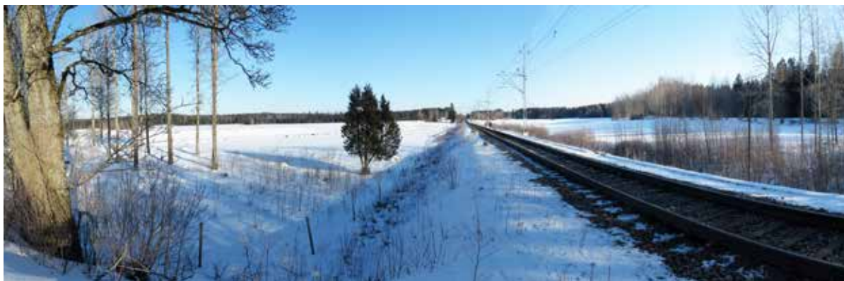
Figur 7.15. Befintlig järnväg i riktning norrut sett från f.d. prästgården.
