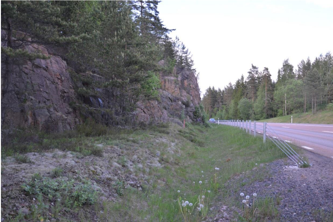
Figur 21. Bergsskärning strax norr om Grossbolstorp.
