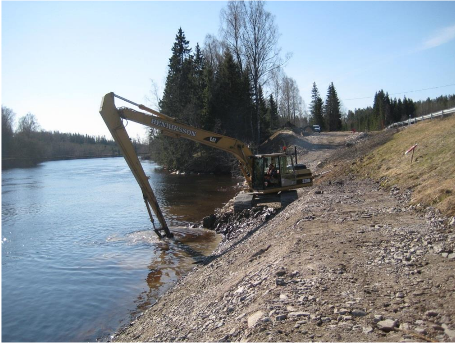
Figur 7. Byggnation av erosionsskydd i Klarälven.
