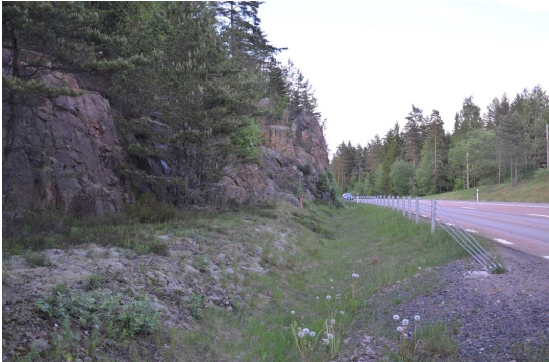
Figur 23. Bergsskärning strax norr om Grossbolstorp.
