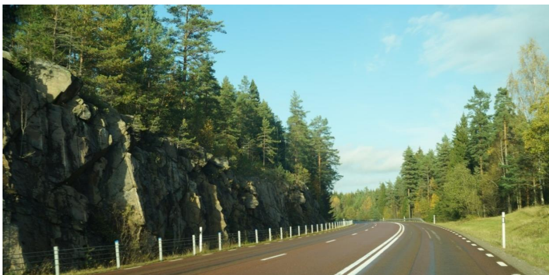
Figur 7. Sträckan går över berg och flera bergskärningar har behövts sprängas ut när vägen byggdes.
