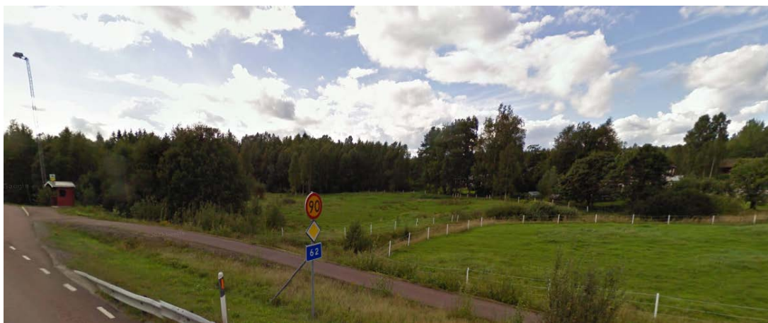
Figur 12. Det öppna diket vid Grossbolstorp. Diket kommer att påverkas av en ny påfartsväg.
