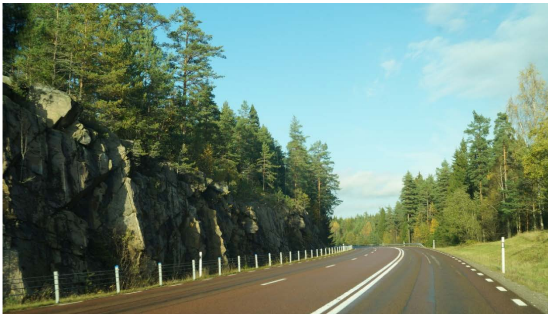
Figur 5. Sträckan går över berg och flera bergskärningar har behövt sprängas ut när vägen byggdes.
