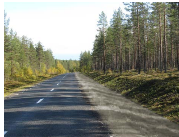
I mitten illustration av en tänkt situation efter ombyggnad med en ytterslänt som täckts med finkornigt material/avbaningsmassor. Detta ska eftersträvas i projektet. Efterhand självvetaberas vegetation även på innerslänten och vägen får en bättre förankring i landskapet.
