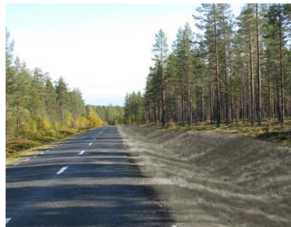
I mitten illustration av en tänkt situation efter ombyggnad med en ytterslänt som täckts med finkornigt material/avbaningsmassor. Detta ska eftersträvas i projektet. Efterhand självvetaberas vegetation även på innerslänten och vägen får en bättre förankring i landskapet.
