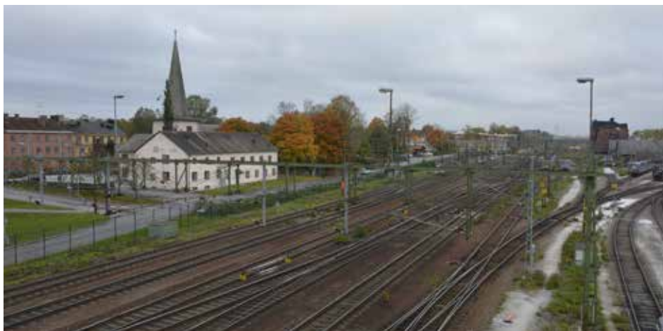
62. Hallsberg rangerbangård, sett i riktning mot väster.
