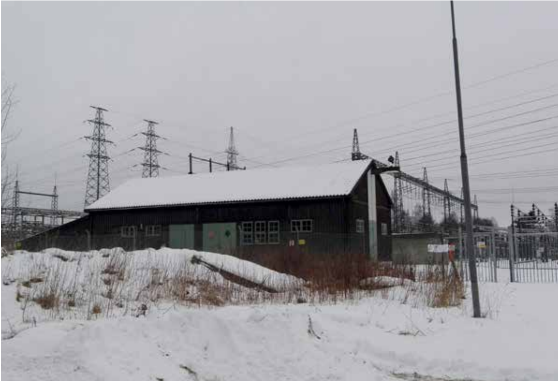
26. Magasinsbyggnad, troligtvis användning med koppling till järnvägens elförsörjning.
