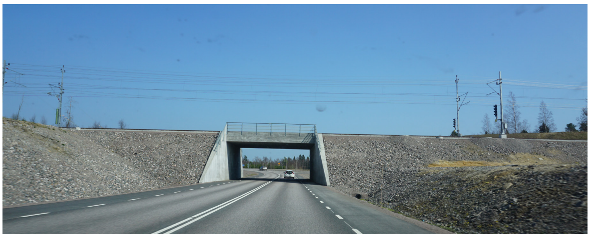
Figur 4 Fotot visar hur en järnvägsbro kan påverka åskådarperspektivet från vägen negativt. De höga bankarna och den smala öppningen över vägen gör att överblickbarheten över landskapet försvunnit. Här visas också vikten av att välja ett bra ytskikt till bankarna; grovt stenkross möjliggör inte en god anpassning till landskapet.
