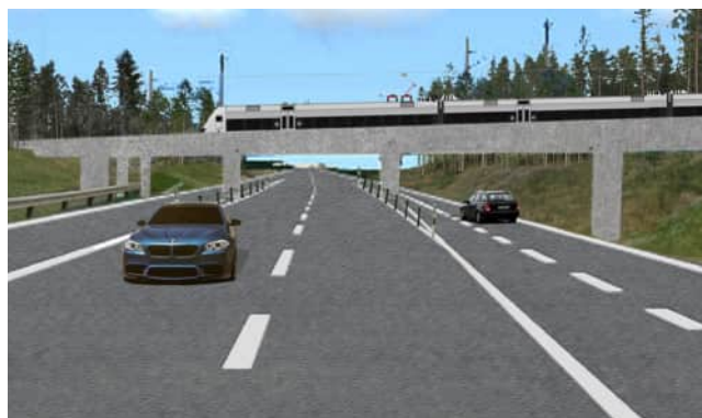
Figur 7.12. Bro över riksväg 50
