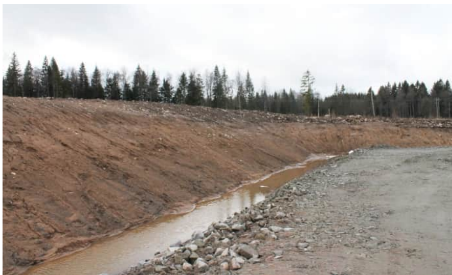
Figur 19 - Markmodelleringarna görs rundade snarare än tekniska. Bilden visar en teknisk lösning med bankar som inte smälter in i omgivningen. Mjukare övergångar vid slänkrön- och fot ska göras.
