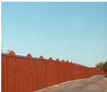
Figur 36 - Ovanstående bilder visar exempel på plank i trä försedda med ljudabsorbenter. Den översta bilden visar exempel på ljudabsorbenter som ska riktas mot järnvägen.
