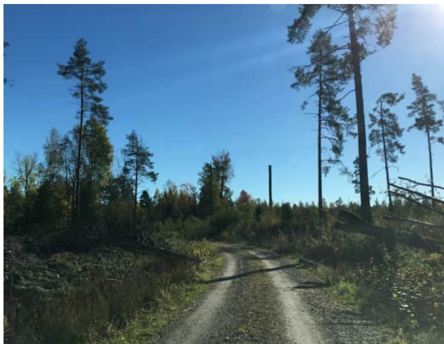
Figur 42 - Bilden visar en skogsväg i Tripphultsområdet som ska byggas om till arbetsväg. Entreprenören blir ansvarig för att bredda vägen till 6 m och får ansvaret att anpassa byggvägen till landskapet på bästa sätt inom en 20 m bred korridor.
