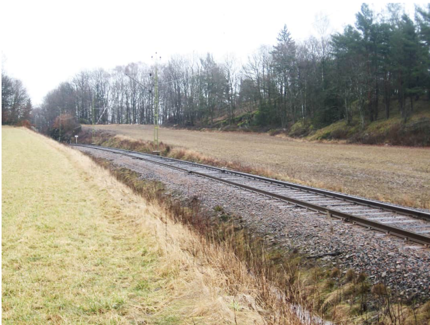
Figur 22 - På bilden visas en fint anpassad övergång mellan bank och skärning.
