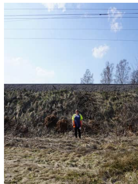
Figur 11 - Bilden visar hur en befintlig järnvägsbank är en påtaglig barriär i landskapet som skär av siktlinjer och som hindrar framkomligheten.
