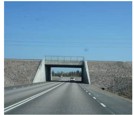
Figur 29 - Vid anläggning av järnväg är det viktigt med ytskikt som får järnvägsbanken att smälta in i landskapet. Fotot visar en järnvägsbank vars slänter täcks av grov stenkross vilket inte är ett lämpligt material för en god visuell anpassning till landskapet. En vegetativ slänt med rätt artanpassning är ett bättre alternativ.
