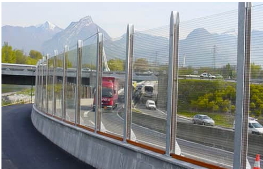
Figur 38 - De transparenta bullerskärmar på bron över Bladsjön tillverkas av transparenta polykarbonatskärmar som reflekterar ljudet.
