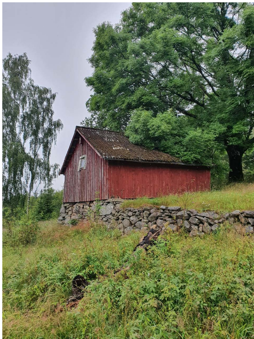
Figur 46: Ekonomibyggnad vid Stensås norra gård. Byggnadens kallmurade grund är sammanbyggd med den murade terrassering som avgränsar gårdsplanen från omgivningarna. Alldeles intill står en högvuxen ask.
