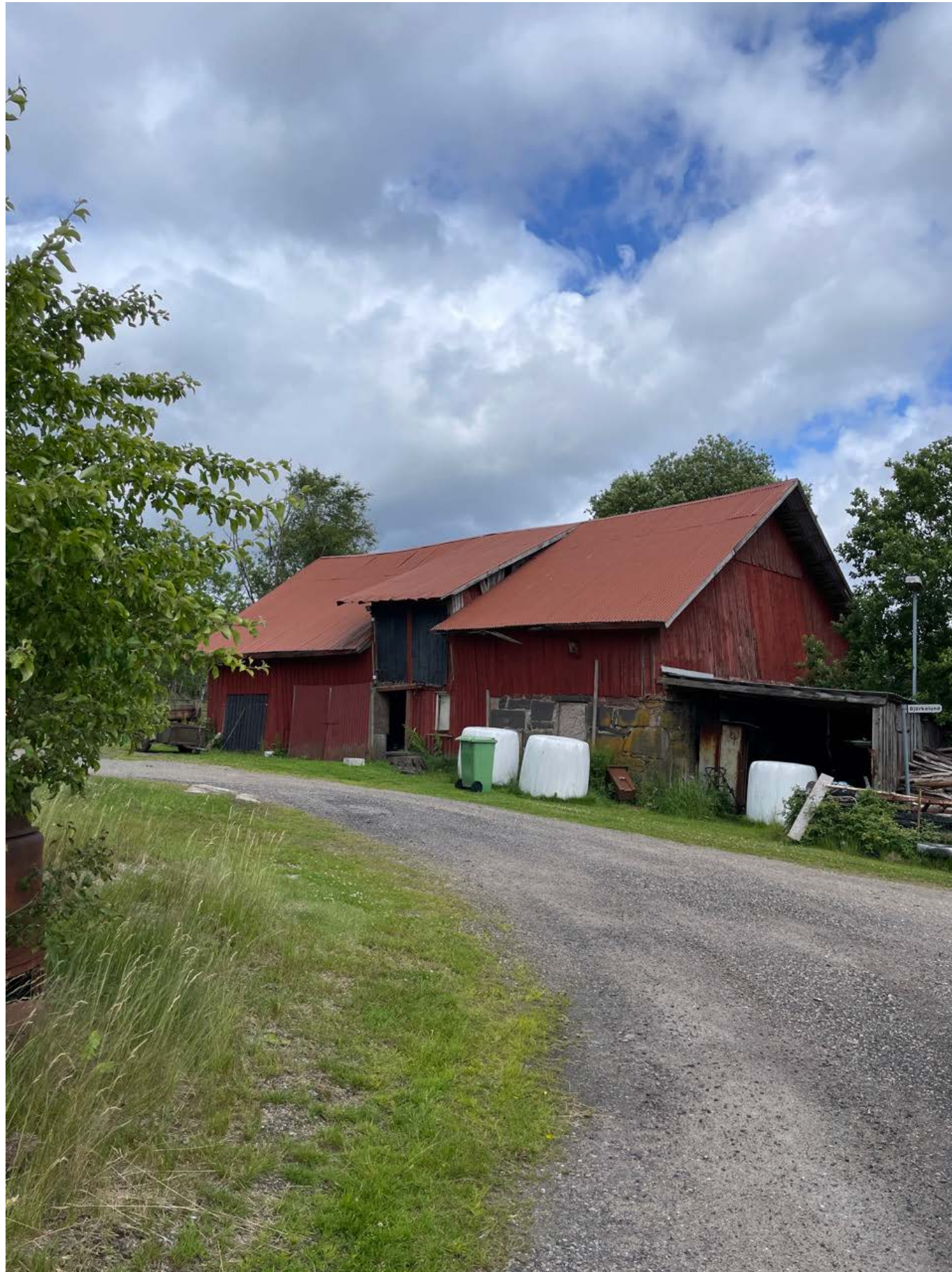
Figur 68: Lövåsens större ekonomibyggnad. Den ena sidan är delvis uppmurad av stora naturstensblock.
