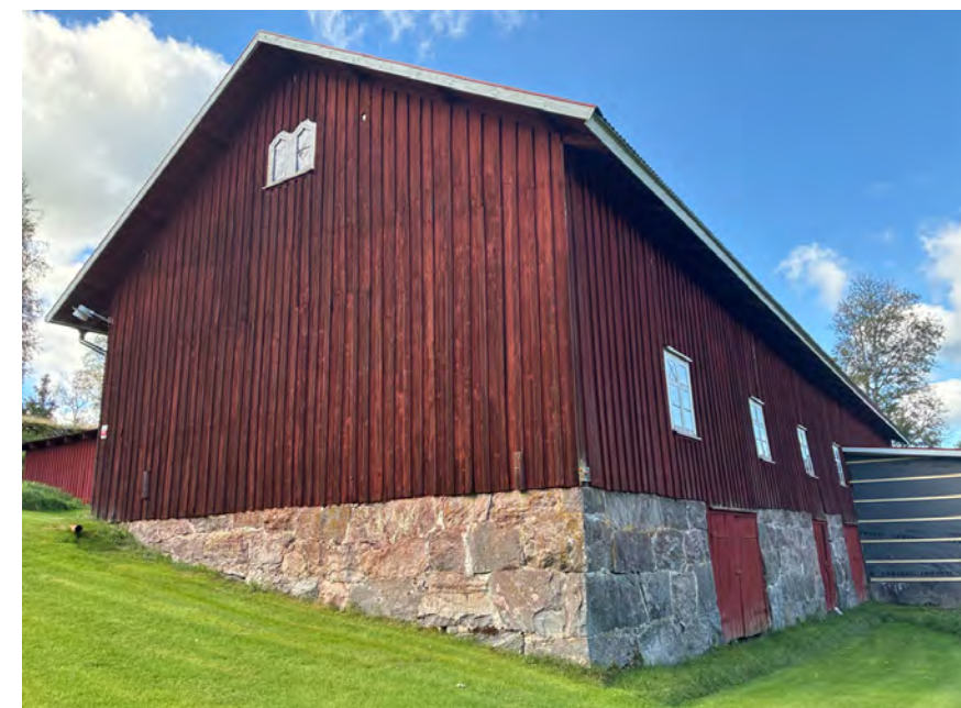
Figur 28: Stor ladugård på stengrund från tiden kring sekelskiftet 1900. Byggnaden har anpassats efter den kraftigt sluttande terrängen.
