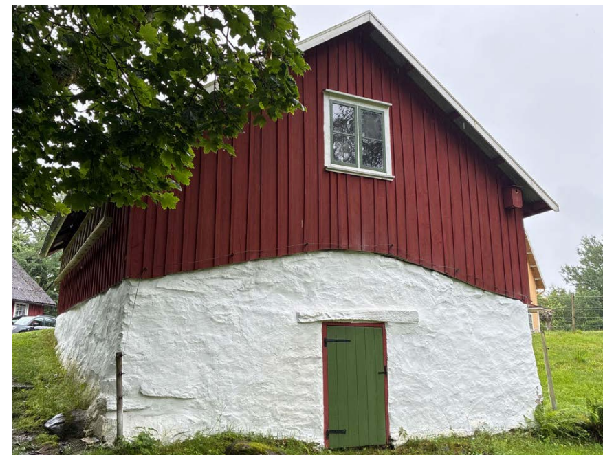
Figur 39: Stor vitkalkad jordkällare med påbyggd övervåning vid stamfastigheten. Det är troligt att källaren är gårdens äldsta bevarade byggnad.
