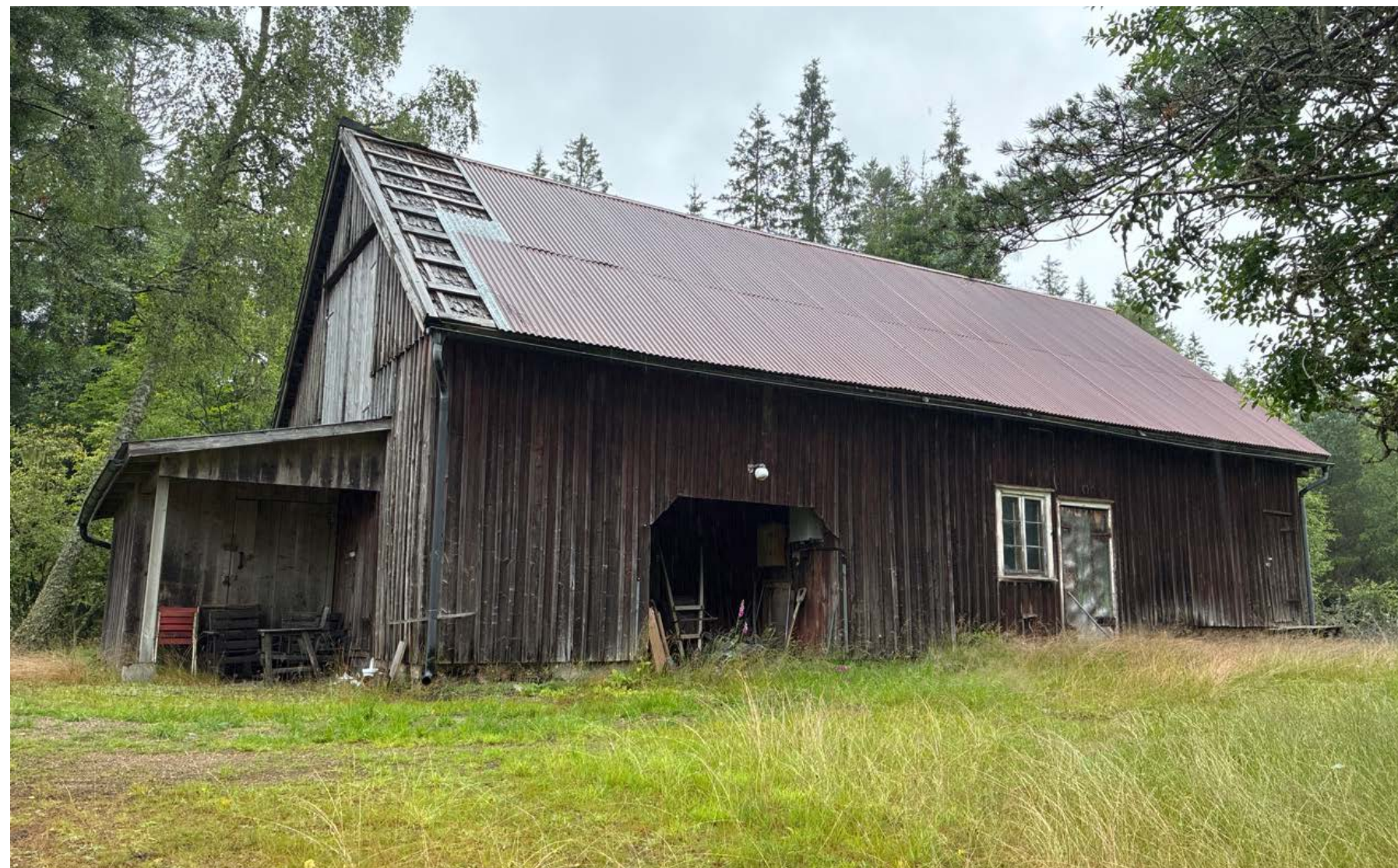
Figur 2: Exempel på ekonomibyggnad med entrén indragen i fasadlivet, i regionen vanligtvis kallad skonke, utskott eller skullutskott.
