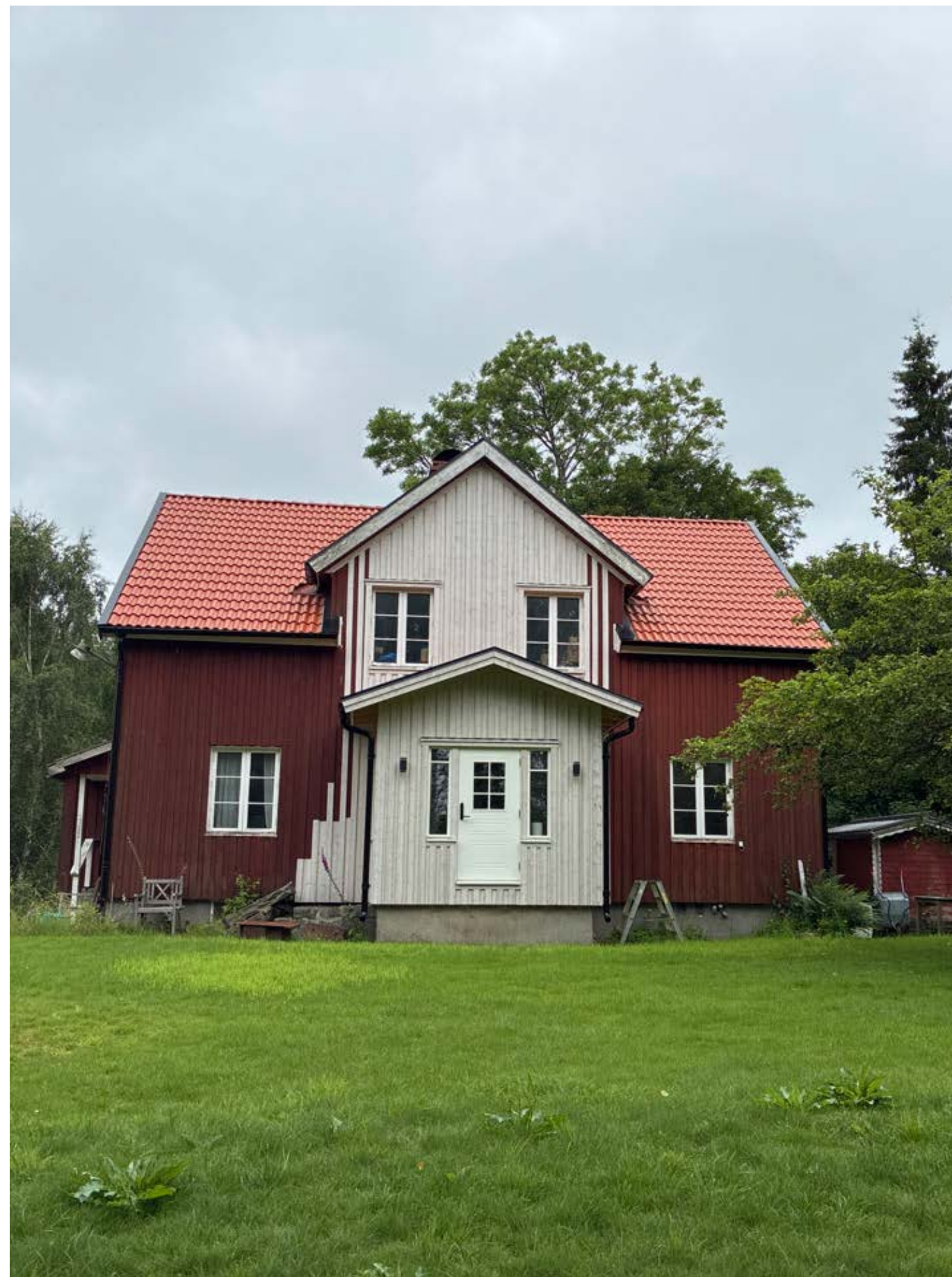
Figur 61: Bostadshus karaktäristiskt för 1900-talets första decennier. Vid fototillfället genomgick byggnaden ett panelbyte.
