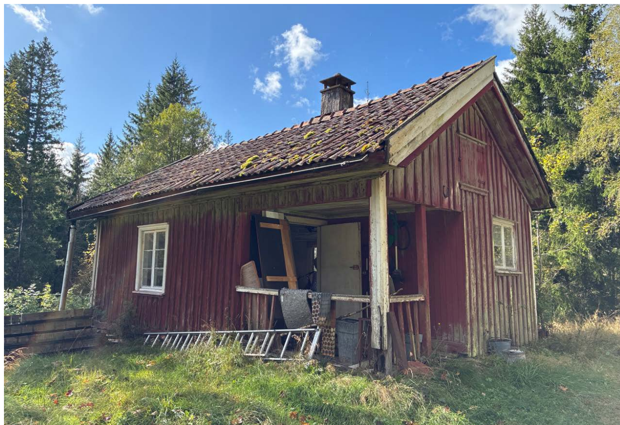
Figur 34: På Lönåsen finns en mindre ekonomibyggnad med välbevarad äldre karaktär som har en ovanlig utformning med indragen entré över ett av hörnen.
