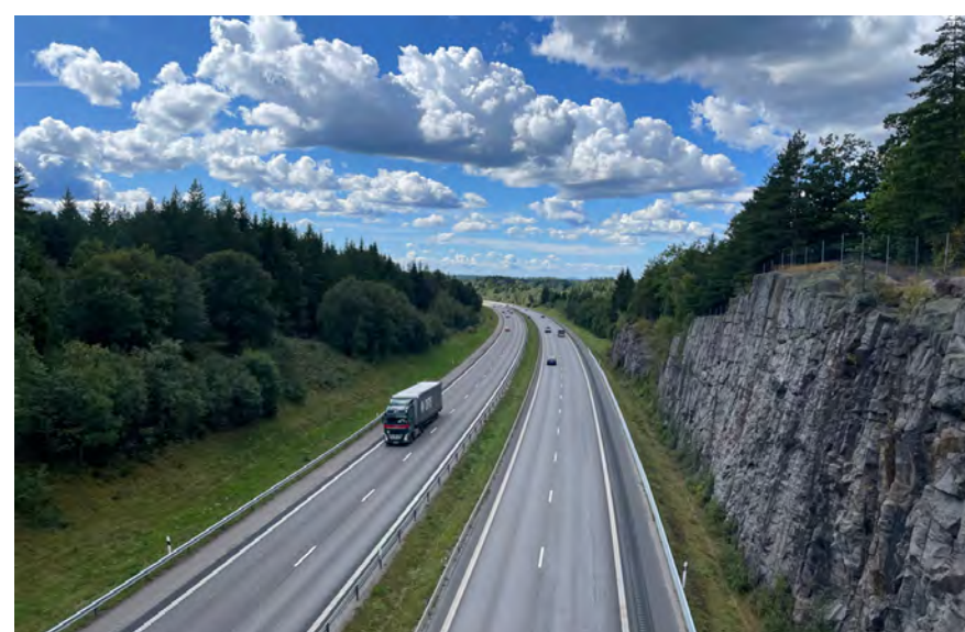
Figur 3: Landskapet präglas till stor del av anläggandet av väg 40 på 1970-talet.
