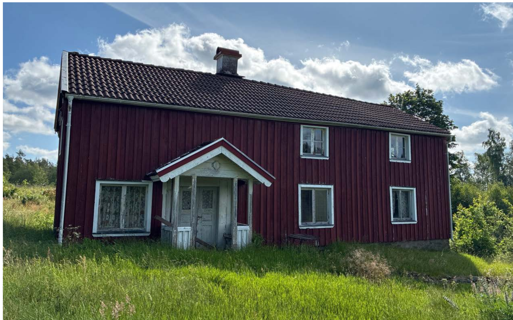
Figur 6: Exempel på en framkammarstuga i korridoren. Stugtypen är en vidareutveckling på den mindre enkelstugan, med ytterligare rum tillagt på ena gaveln.
