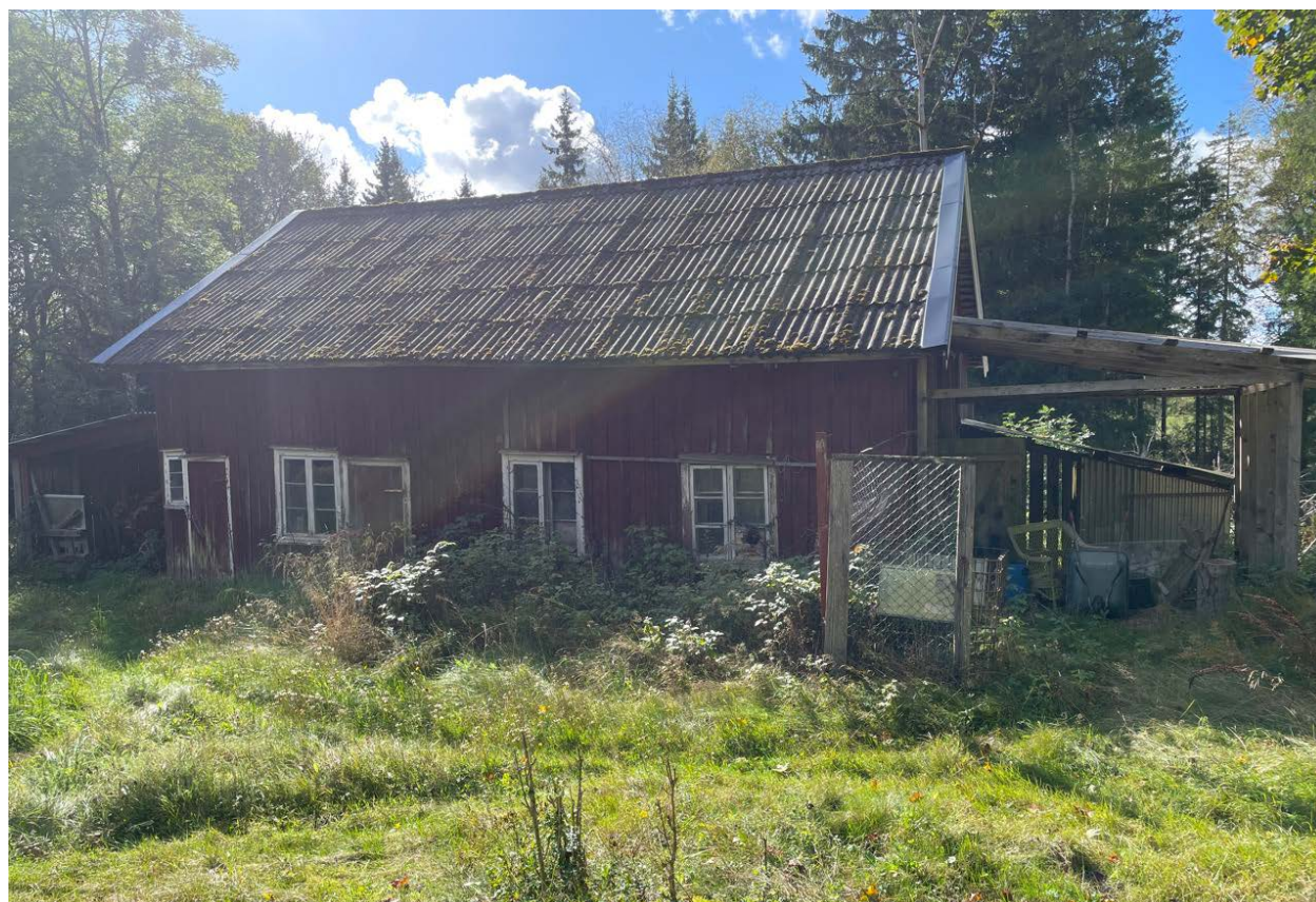
Figur 35: Den andra ekonomibyggnaden har ursprungliga byggnadsdetaljer som bräddörrar och spröjsade fönster. På taket ligger korrugerad eternit.
