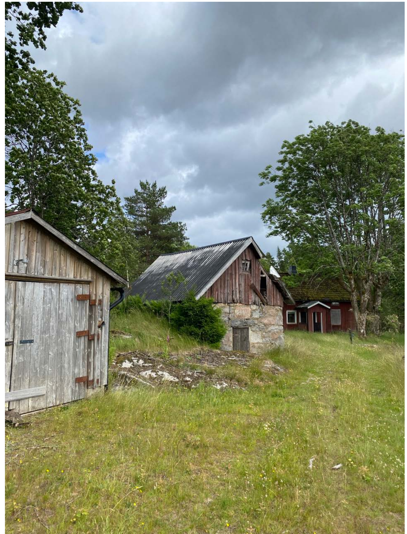
Figur 72: Jordkällare murad av stora naturstensblock och i bakgrunden syns bostadshuset med vådräd.
