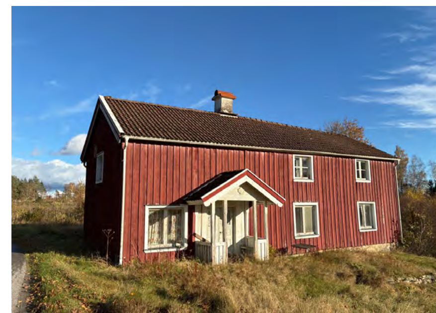
Figur 54: Framkammarsstuga som genomgått förändringar i form av tilläggsisolering och byte av bottenvåningens fönster, farstukvisten är äldre.
