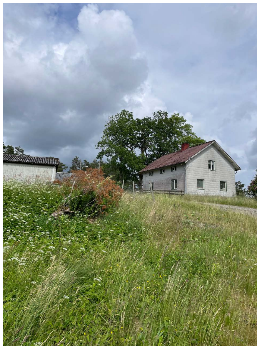
Figur 47: Stensås norra gård har ett bostadshus som under första halvan av 1900-talet moderniserats med en eternitfasad.
