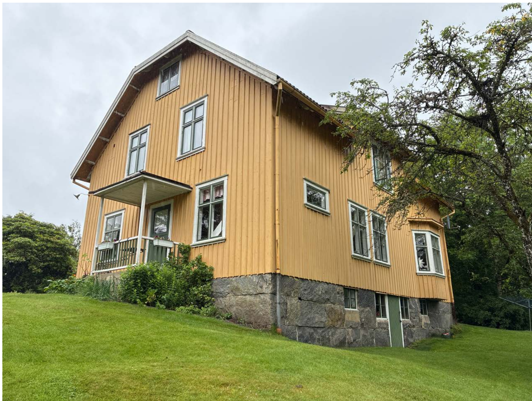
Figur 38: Foto av bostadshuset som hör till Låddekärnsbus stamfastighet. Gården är äldre men det nuvarande bostadshuset uppfördes på 1930-talet.
