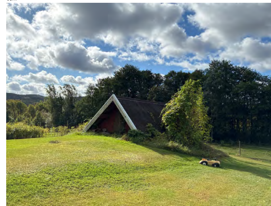
Figur 22: Källarvind med välbevarad äldre karaktär tillhörande fastigheten Forsa 1:10.
