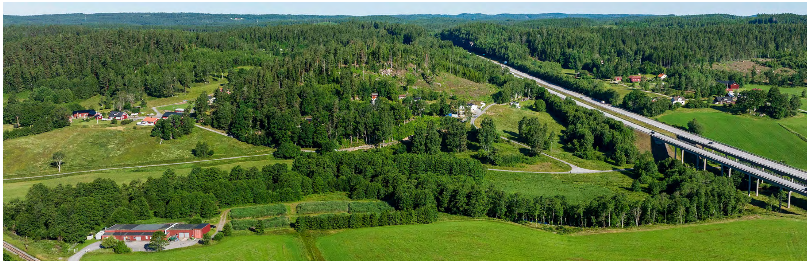
Figur 39: Vy mot väster som visar området vid Kullen, där bebyggelsen ligger på vardera sida om den skogsklädda höjden. Väg 40 till höger i bild.
