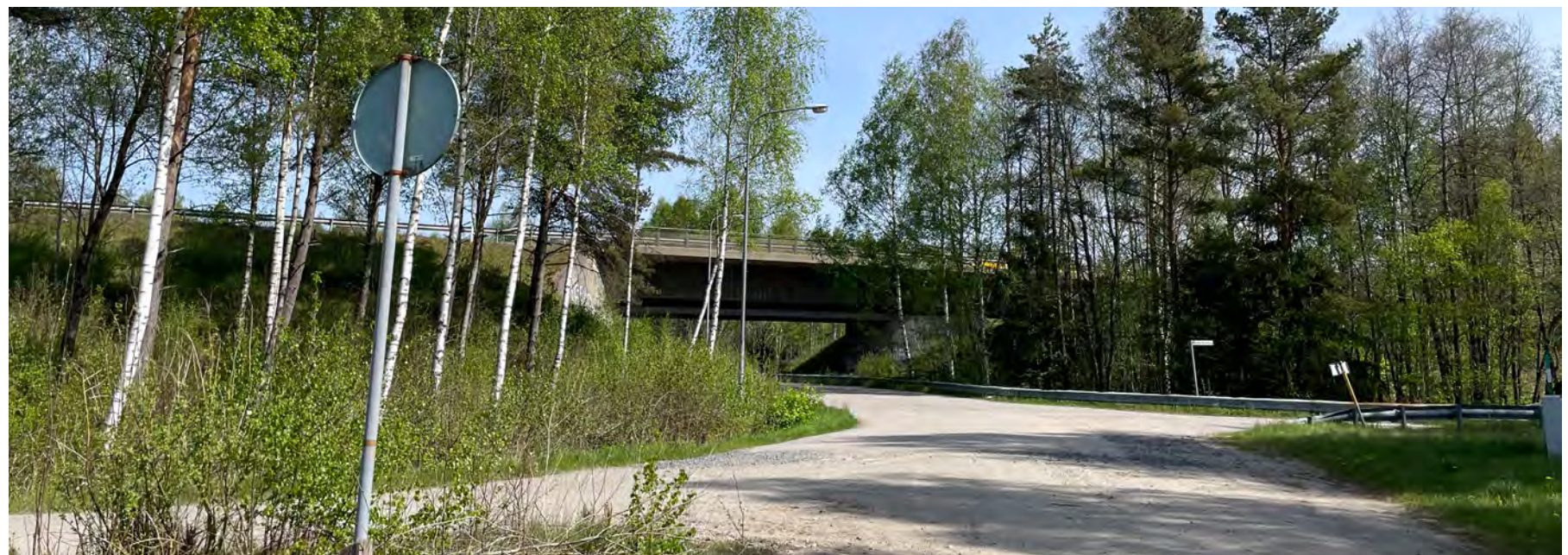
Figur 19: Passage under väg 40 vid Bollekollen, riktning mot Bollebygds centrum.
