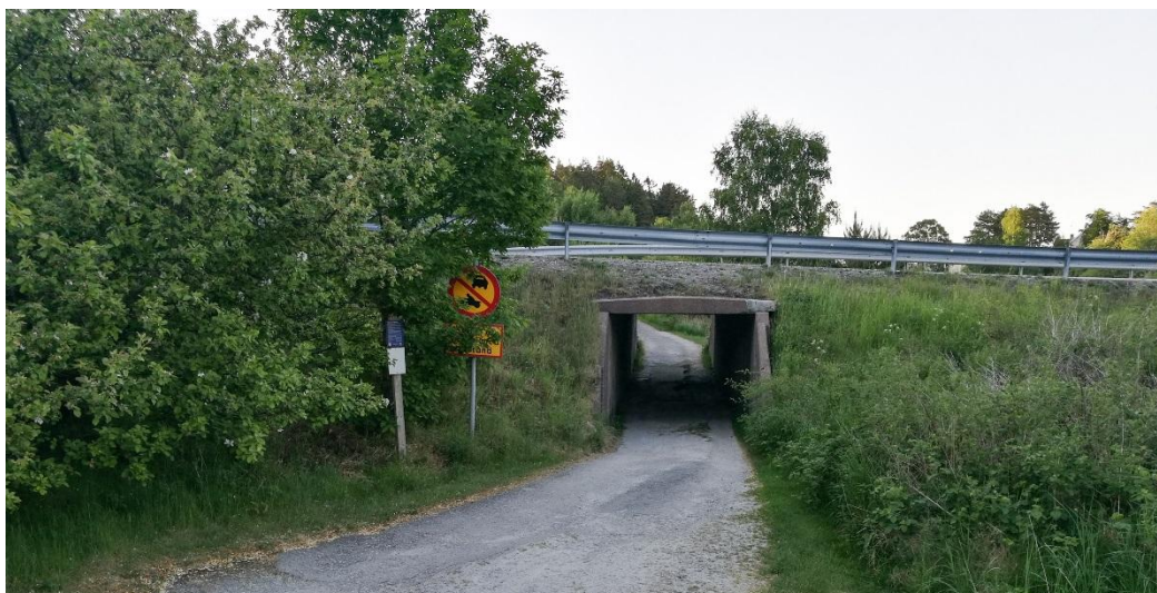
Figur 16. Vägport vid Sörbyvägen. Bild tagen mot norr.
