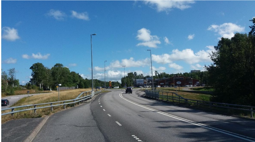
Figur 7. Bro och busshållplatser strax innan cirkulationen i Myggenäs centrum. Almösundsvägen till vänster. Foto mot öster.
