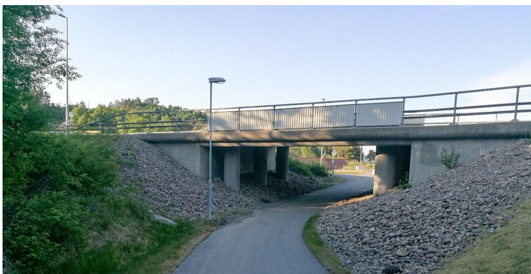
Figur 17. Gång- och cykelväg under bro tillhörande väg 160 väster om cirkulationen i Myggenäs centrum. Bild tagen mot norr.
